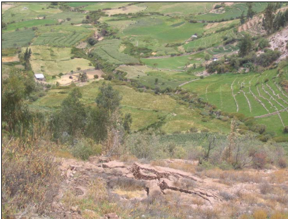
Fig. 6: Grietas de hasta 2 metros de ancho a lo largo del deslizamiento.
