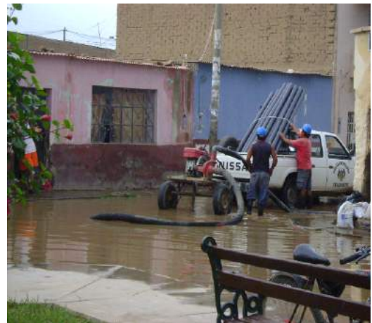
Sobrecargas al sistema de alcantarillado con aguas lluvias.
