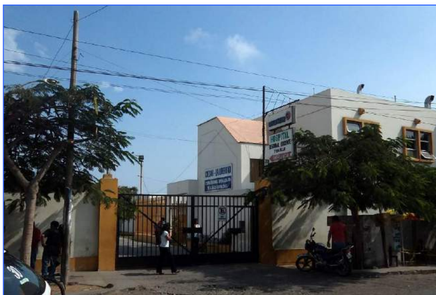
Fotografía N°17: Unidad de Emergencia del Hospital Regional Docente de Trujillo
