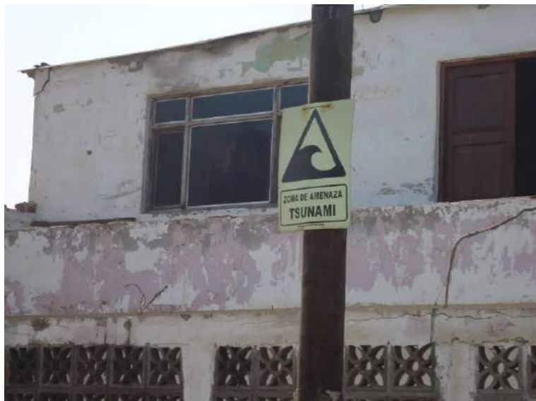
Fotografía N° 22: Señalización de zonas de peligro en el balneario de Víctor Larco – Equipo SIRAD Trujillo 2012
