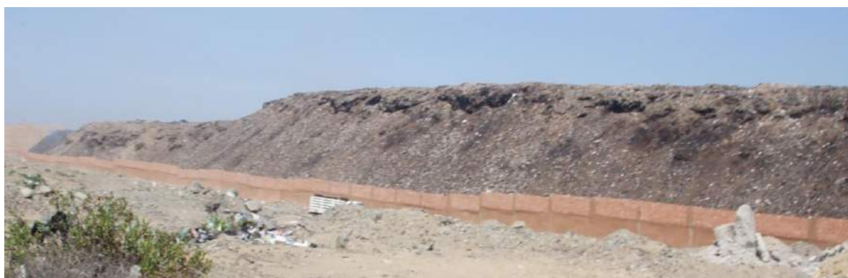
Fotografía N° 29: Botadero Controlado El Milagro - Equipo SIRAD-Trujillo 2012
