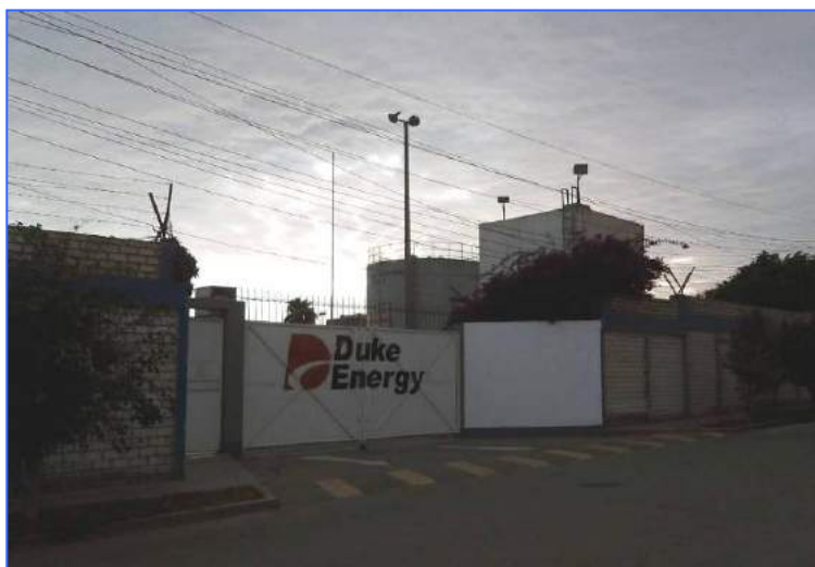
Fotografía N° 16: Central Termoeléctrica propiedad de Duke Energy - EGENOR
