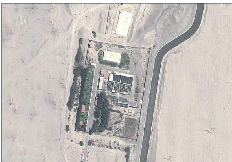
Fotografía N° 13: Planta de Tratamiento de Agua Potable Alto Salaverry
