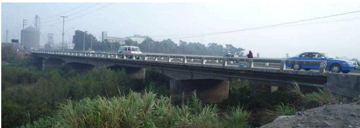
Fotografía N° 18: Puente Moche – Equipo SIRAD Trujillo 2012
