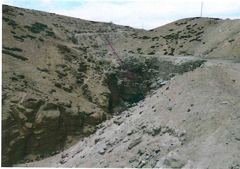
Foto 8. Cauce de la quebrada Del Diablo obstruido por trocha de acceso a las granjas de aves en el cerro Alto de la Alianza.
