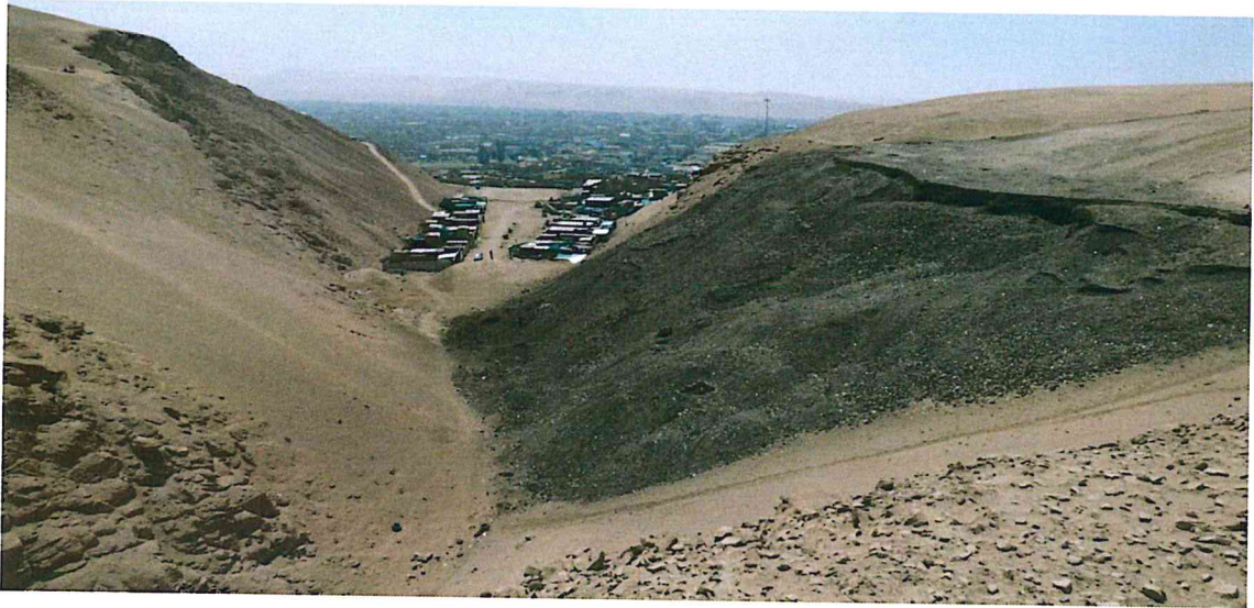
Foto 6. Vista Panorámica de la quebrada Del Diablo, la Asociación de Vivienda La Florida, se encuentra sobre el cauce, en la margen izquierda presenta derrumbes y en la margen derecha, el antiguo botadero municipal de la ciudad de Tacna.
