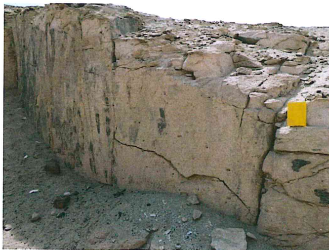
Foto 1. Ignimbritas de color pardo rojizo muy fracturado, presenta aberturas abiertas con rellenos de yeso en las juntas, en ambas márgenes de la quebrada del Diablo.
