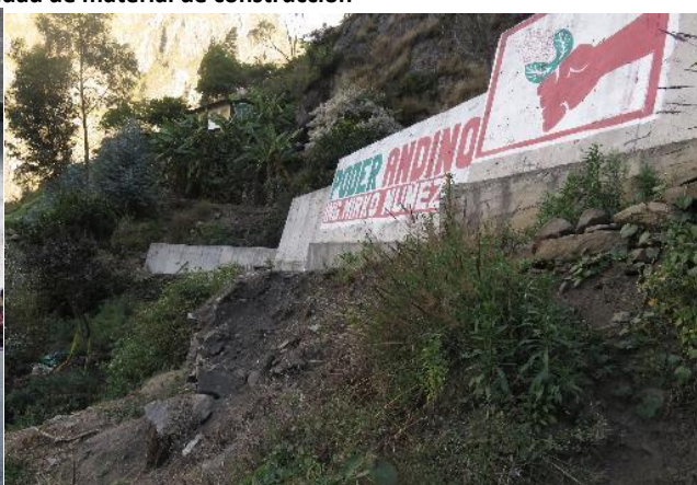
Construcción en ladera
