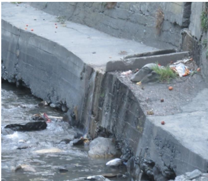
Ilustración 24 Vertedero del desagüe al río Sandía
