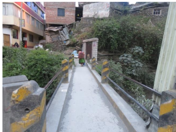
Vía de acceso a comunidades
