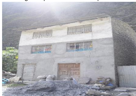
Vivienda de tres pisos en piedra y barro con revestimiento de yeso y cemento
