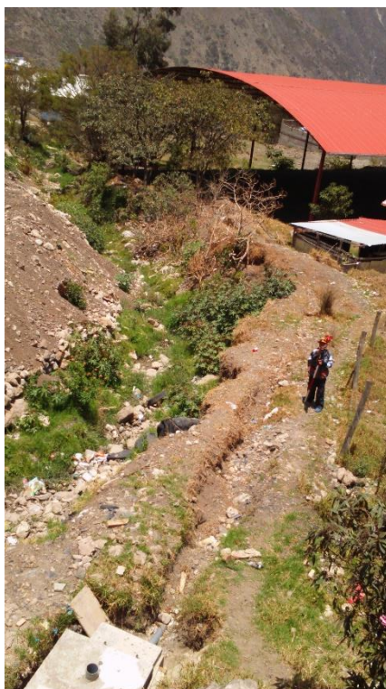
Cauce del río invadido por material de desmote y centros recreacionales.
