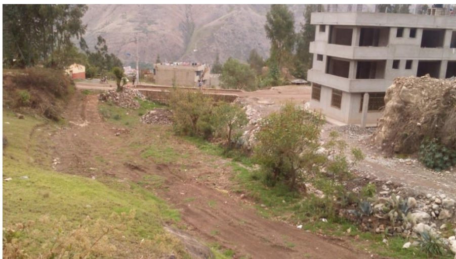
Viviendas asentadas dentro de la faja marginal de la quebrada.
