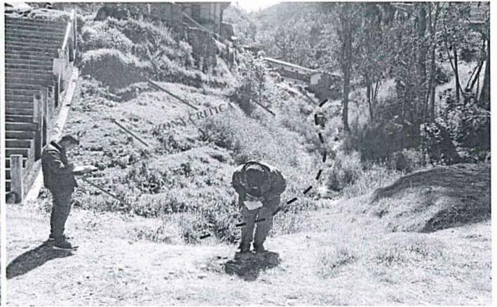
Vista de Viviendas con posible afectacion en el Distrito de Santiago de Challas, en la margen derecha
