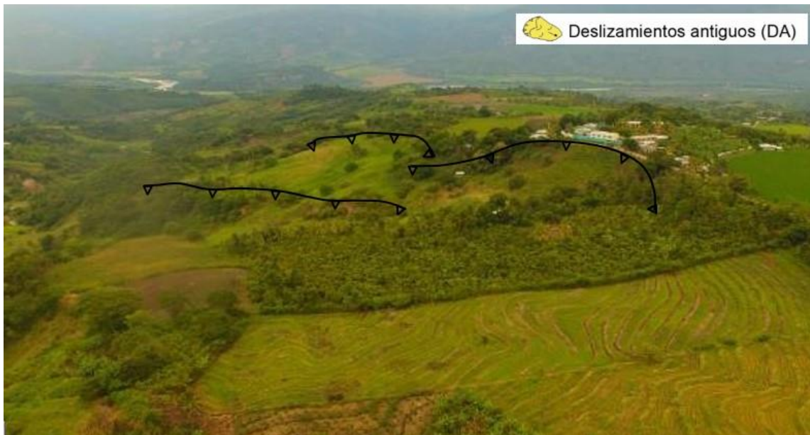
Figura 12. Deslizamiento antiguo próximo al área urbana de El Tigre.
