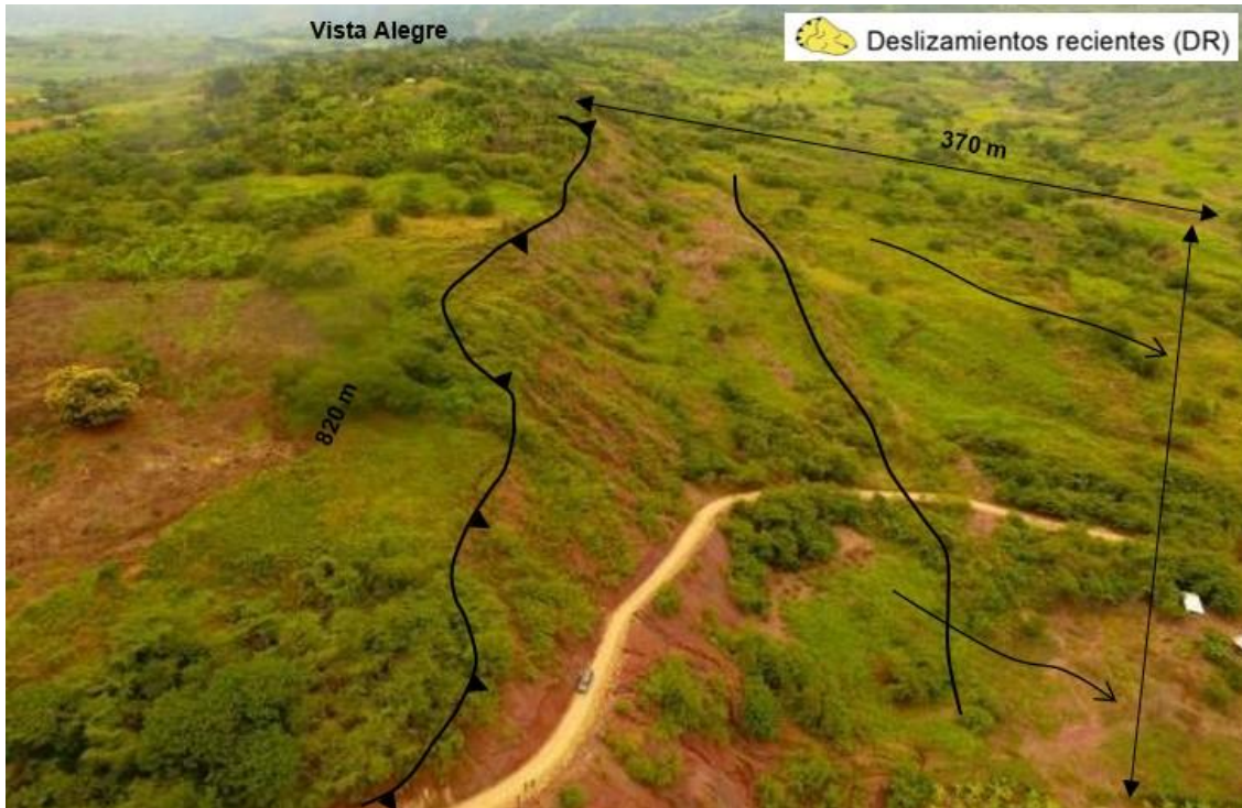
Figura 14. Deslizamiento DR-01 que afecta la vía de acceso hacia San Miguel.
