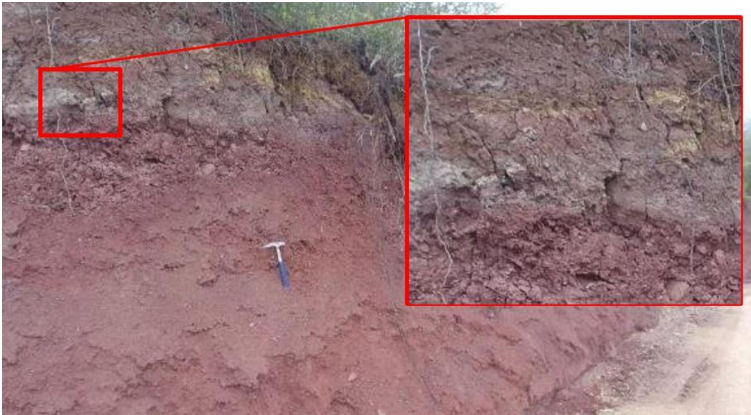
Figura 20. Capas sedimentarias que constituyen los primeros metros de suelos de cimentación.
