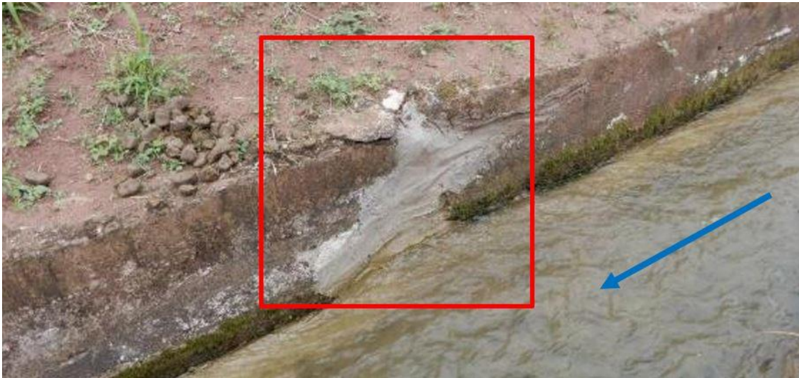
Figura 25. Canal de riesgo El Campesino.
