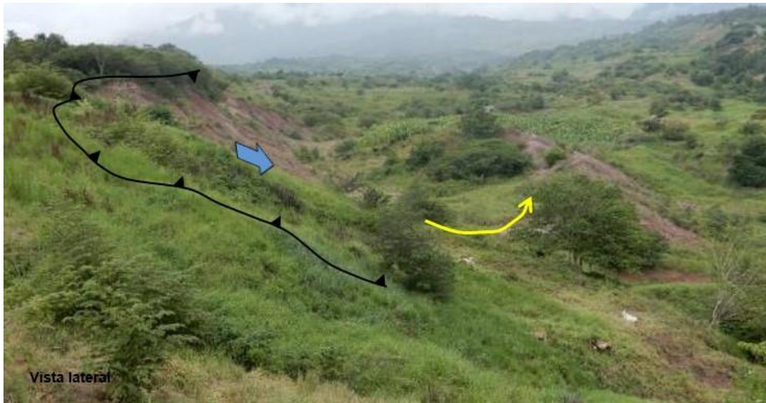
Figura 16. Vistas del escarpe principal y el canal de concreto destruido debido al desplazamiento de los materiales.
