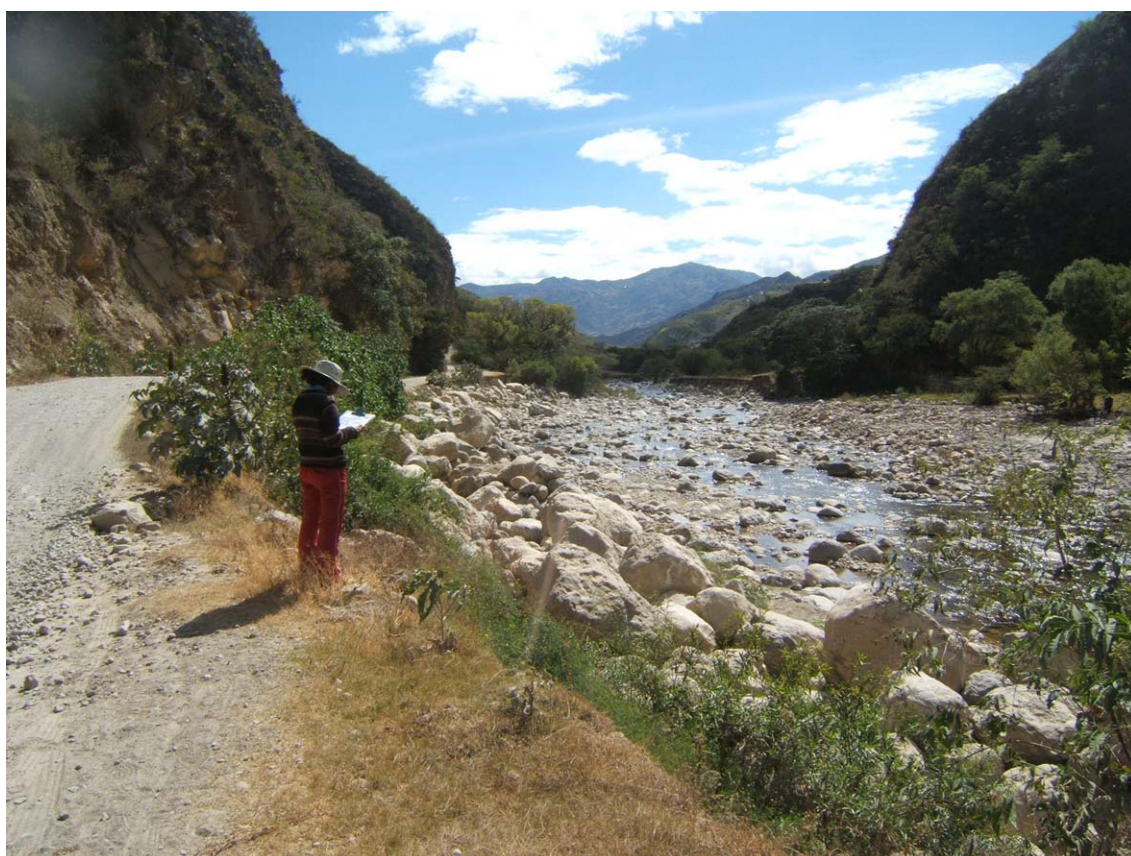
Uso de enrocados para protección de carretera, contra erosión fluvial. En muchos casos esto debe estar acompañado de un levantamiento de la rasante de la carretera. Valle del río Chotano.
