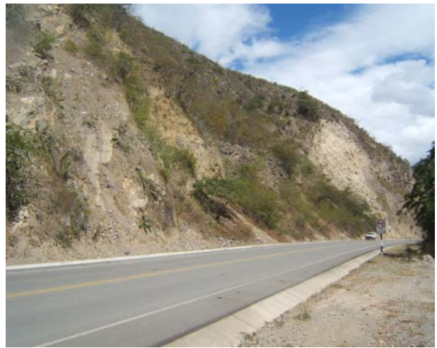
Foto 93 Tramos de la carretera entre Chiple-Santa Rosa de Cavico y Kms. 161-162, que son afectados frecuentemente por caída de rocas y derrumbes.
