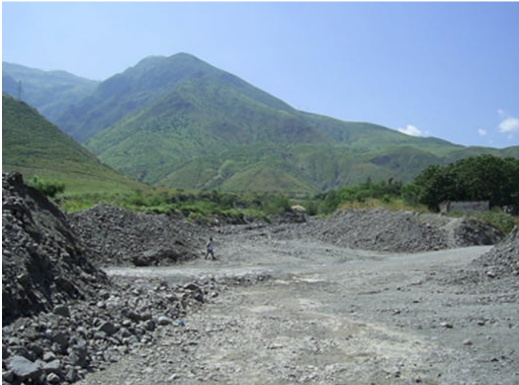
Foto 65 Vista de la quebrada Maramal, por donde discurren huaicos de manera ocasional a periódica, se ha colocado badén (sector Zapotal, San Bernardino, Cajamarca)
