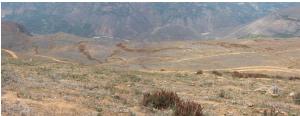
Foto 38 Erosión en cárcavas en el sector de cerro Tayaorco, Cañapampa, carretera hacia Suchubamba y Cospán.
