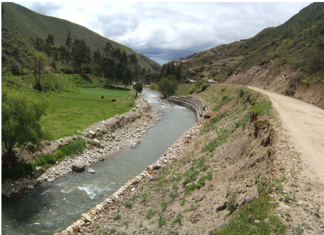
Otra vista de muro de gabiones para protección de plataforma de carretera. Se aprecia el encauzamiento del río, en la terraza baja con arrimado de material para protección de áreas de cultivo.
