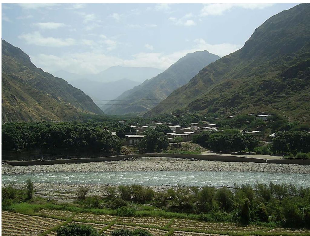
Ejemplo similar al anterior para protección contra crecida y peligro de Inundación en el río Jequetepeque.0
