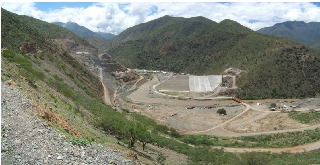
Valle del río Huancabamba, vista aguas abajo. Construcción de presa Limón, proyecto Olmos. En la vista inferior muestra detalle de las obras de estabilización de talud en margen izquierda, con muros de concreto y pernos de anclaje.
