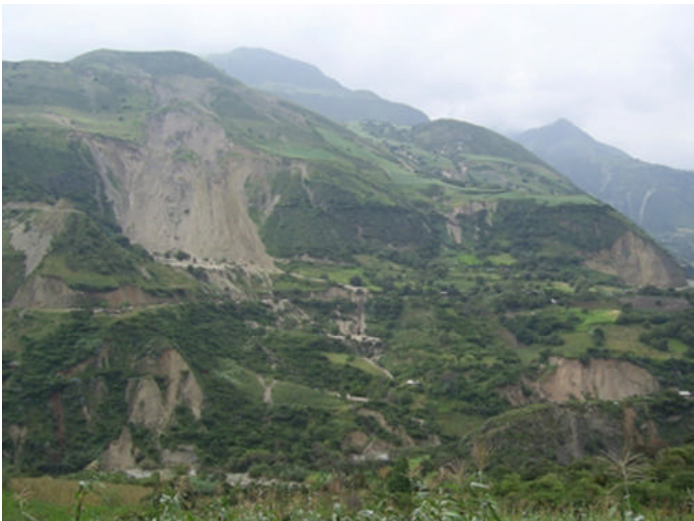
Foto 71 Km. 129+000 de la carretera a Cajamarca, deslizamientos activos producen la pérdida de terrenos de cultivo y carretera.
