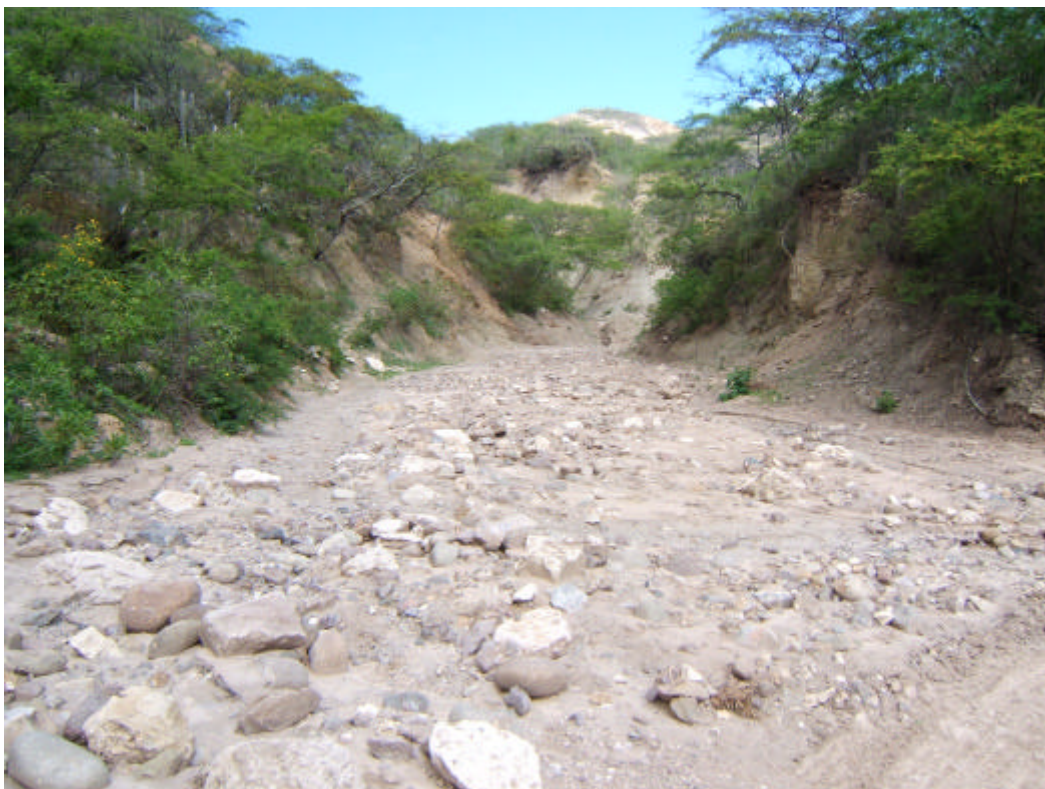
Foto 57 Área susceptible a huaicos, carretera Santa Cruz- Chancay Baños.
