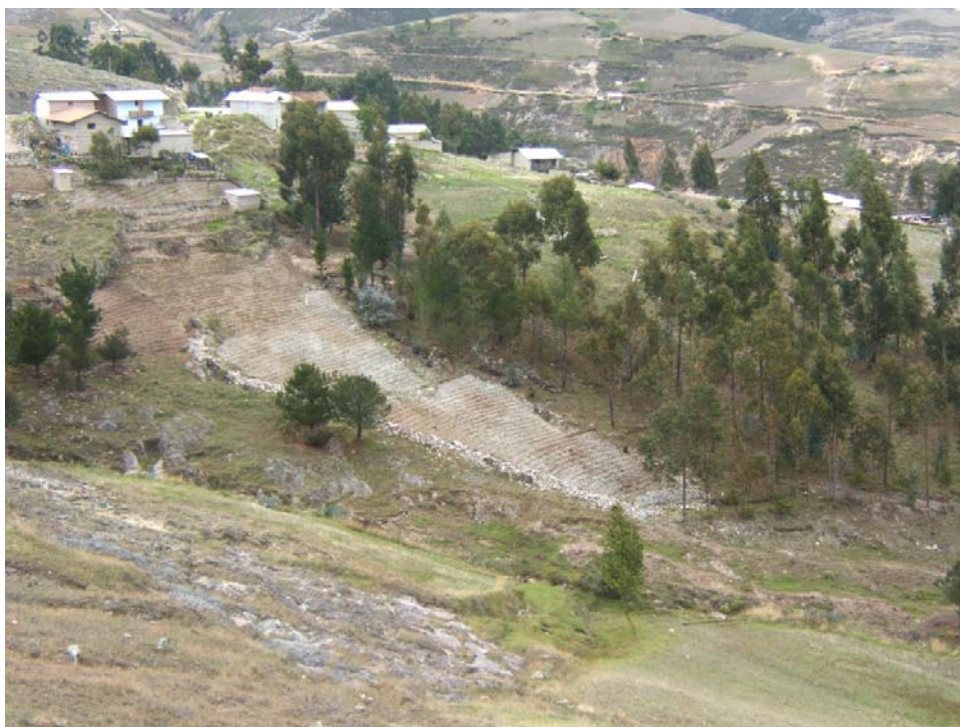
Ladera reforestada en parte y terraceo para control de deslizamiento y reptación de suelos, ladera noroeste de la ciudad de Cajamarca.
