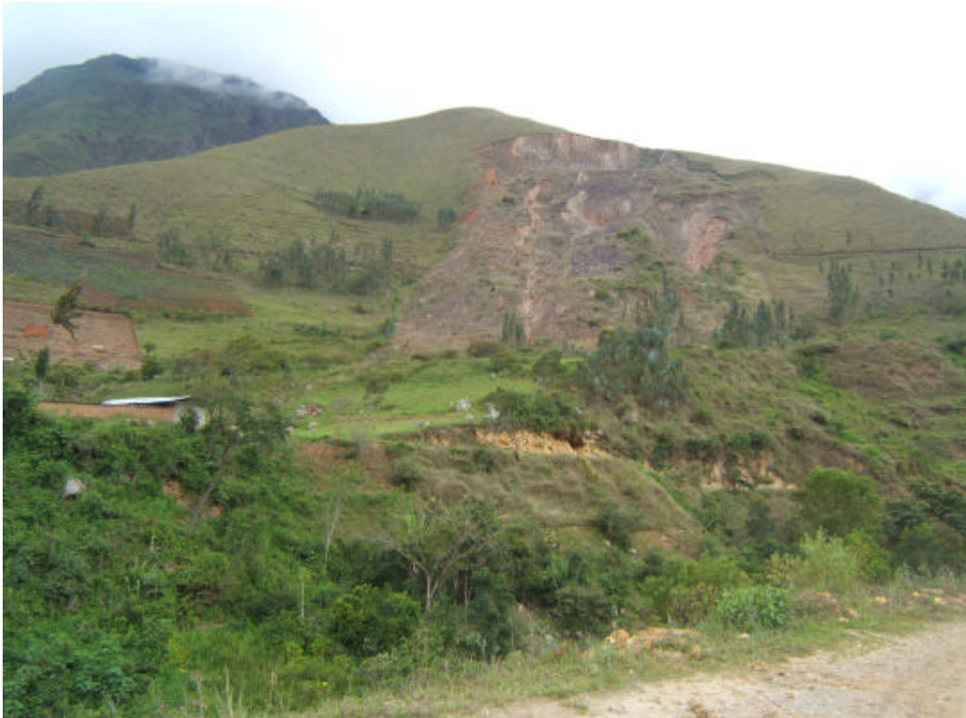
Foto 26 Deslizamiento traslacional en el tramo de carretera Bambamarca-Paccha.
