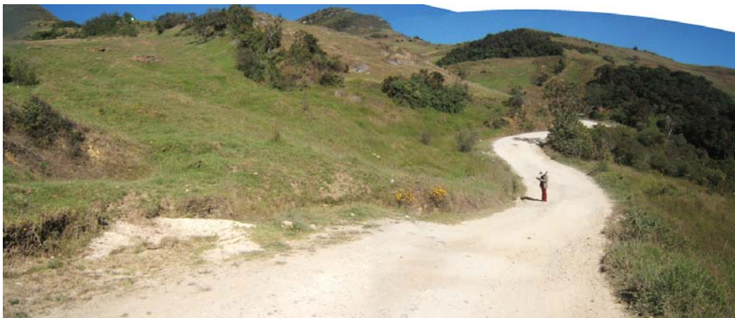
Foto 31 Proceso de deslizamiento-reptación, activo en tramo de la carretera entre Chota y El Verde. Se aprecia el material deslizado en forma de un flujo de tierra.
