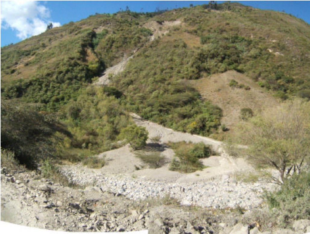
Foto 32 Zona de derrumbes en la ladera con generación de flujos de detritos, en el sector frente a Chamana, carretera Chota-Chiclayo.
