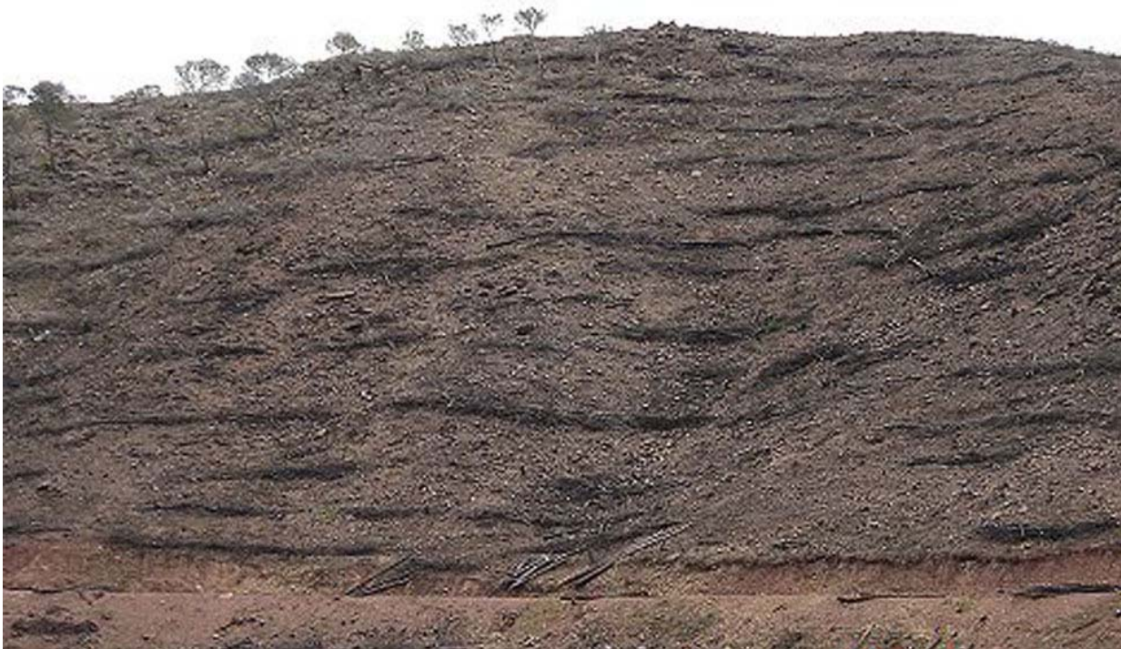
Foto que ilustra la construcción de fajinas de vegetación.
