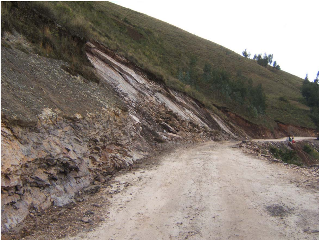
Talud con buzamiento de los estratos en la misma dirección, que originan deslizamientos de tipo trasnacional o planar. En estos casos puede emplearse pernos de anclaje. Se ha forestado la ladera en los alrededores.
