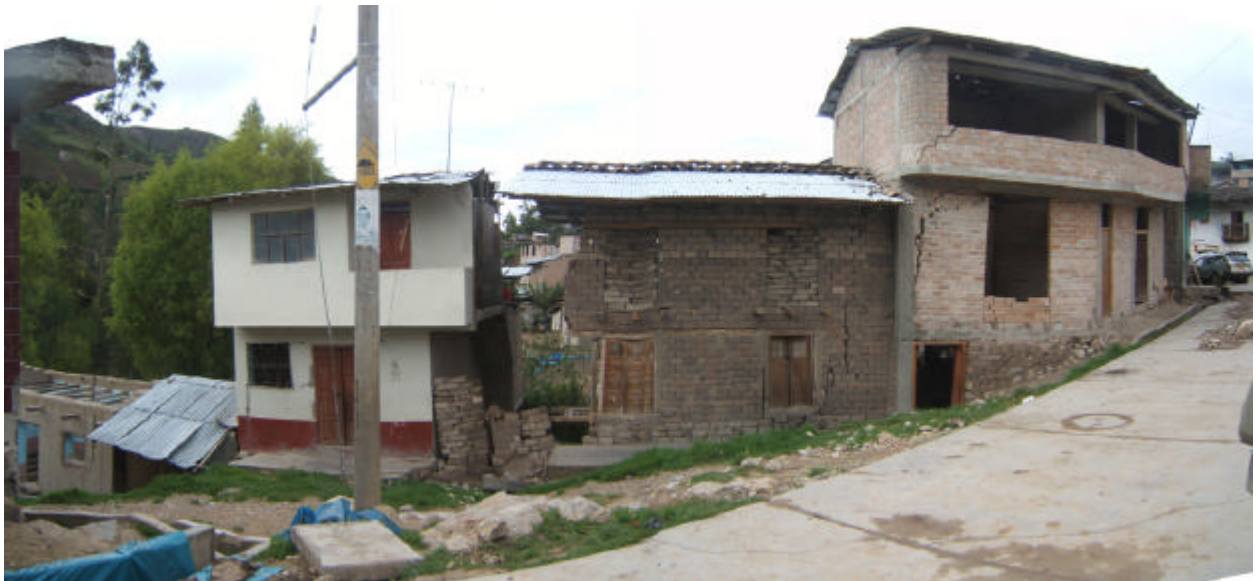
Foto 46 Vistas de daños en las viviendas y áreas de cultivo del Barrio de Cinco Esquinas, Bambamarca, afectado por deslizamiento de tierras.
