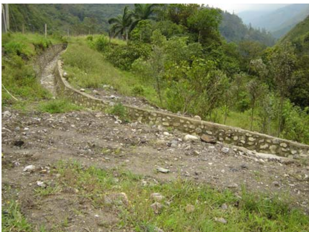
Terraceo de taludes y drenaje de aguas pluviales en taludes de corte de carreteras.
