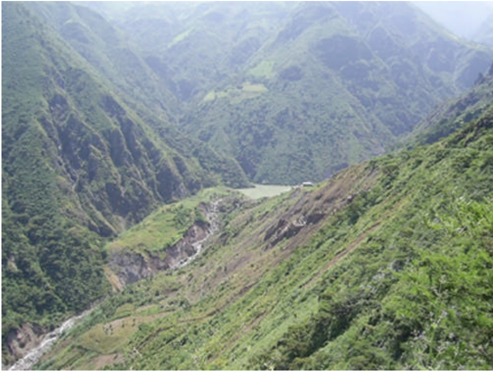
Foto 70 Quebrada El Palto, vista del represamiento producido por un deslizamiento desde la margen izquierda, Magdalena.
