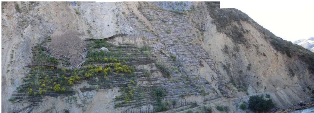
Construcción de trinchos para estabilización de laderas susceptibles a derrumbes.
