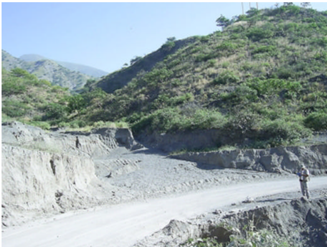
Foto 66 Quebradas por donde discurren huaicos y flujos de lodo de manera excepcional, afectan por tramos a la carretera Chilite-San Pablo.
