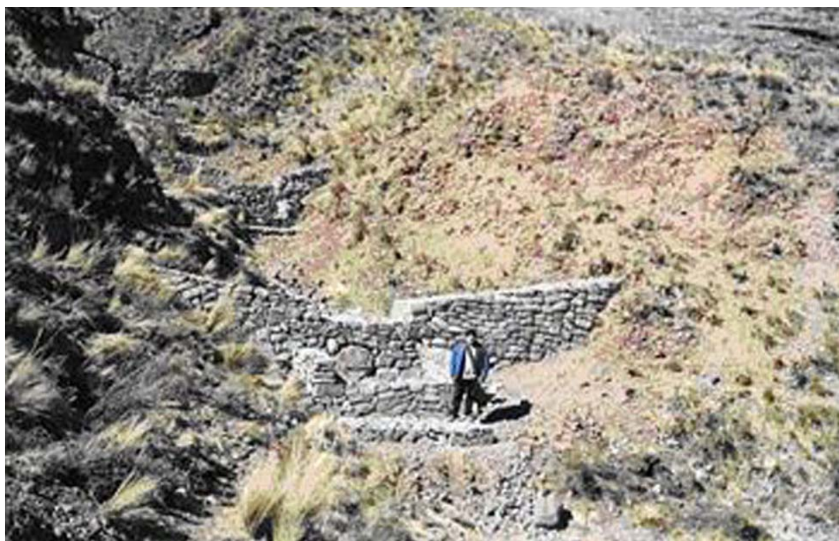
Ejemplo de protección de lecho de quebrada utilizando muros de piedra.
