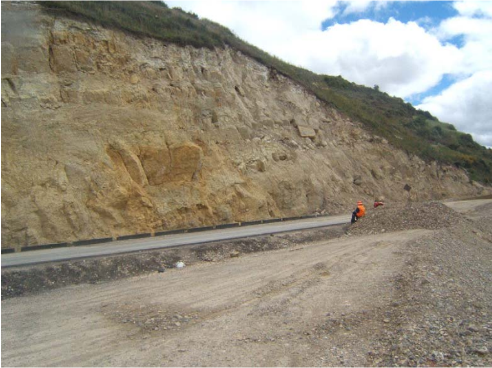
Talud de carretera Cajamarca-Celendín donde se efectúan trabajos de desquinche y «banqueteo» o terraceo, del talud que muestra procesos de caída de rocas y vuelco.
