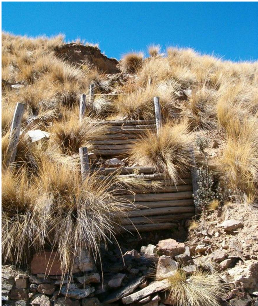
Ejemplo de control de erosión en cárcavas usando material del lugar.
