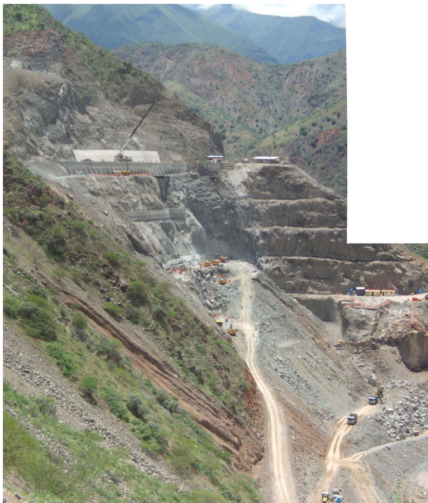
Valle del río Huancabamba, vista aguas abajo. Construcción de presa Limón, proyecto Olmos. En la vista inferior muestra detalle de las obras de estabilización de talud en margen izquierda, con muros de concreto y pernos de anclaje.
