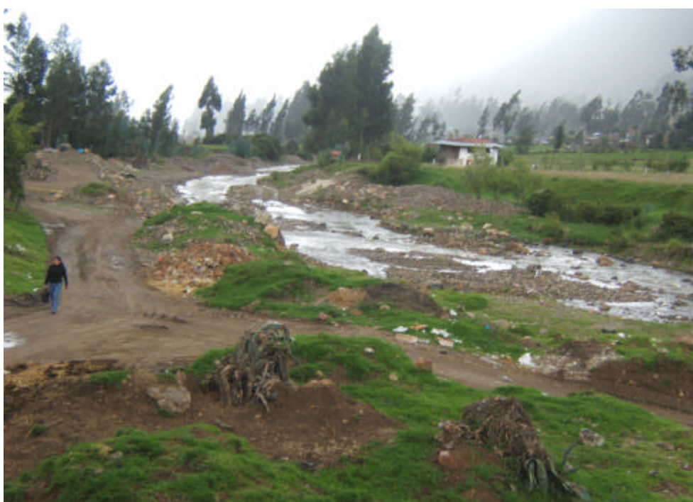
Foto 37 Área susceptible a erosión e inundación fluvial, sector Chonta, Cajamarca.
