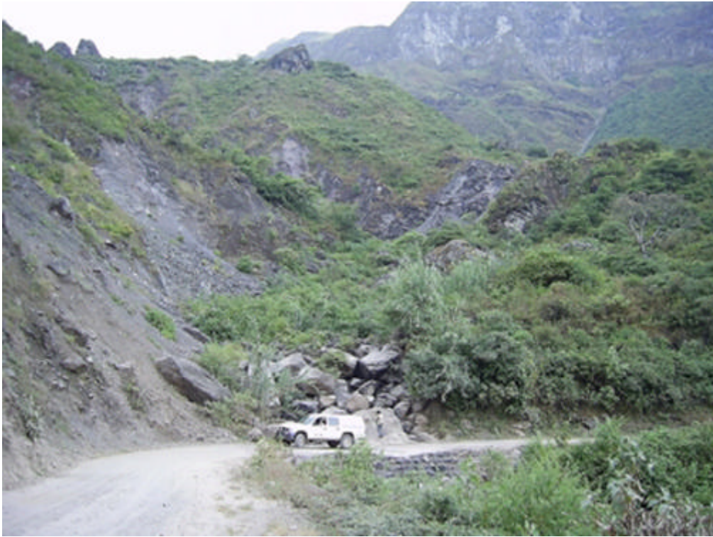
Foto 67 Sector El Palto, en la carretera San Pablo-San Miguel de Pallaquez, afectado por huaicos y deslizamiento en la plataforma de carretera.
