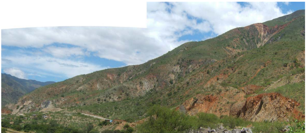
Foto 103 Vistas de frente (superior) y de perfil, de las laderas del cerro Leonero, con presencia de cárcavas, derrumbes cara libre que generan periódicamente flujos de detritos que interrumpen tramo de la carretera Olmos-Corral Quemado.
