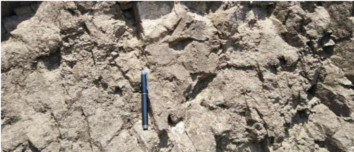
Fotografía 06. Afloramiento de rocas muy fracturadas que constituyen la roca fuente para los flujos y caídas.
