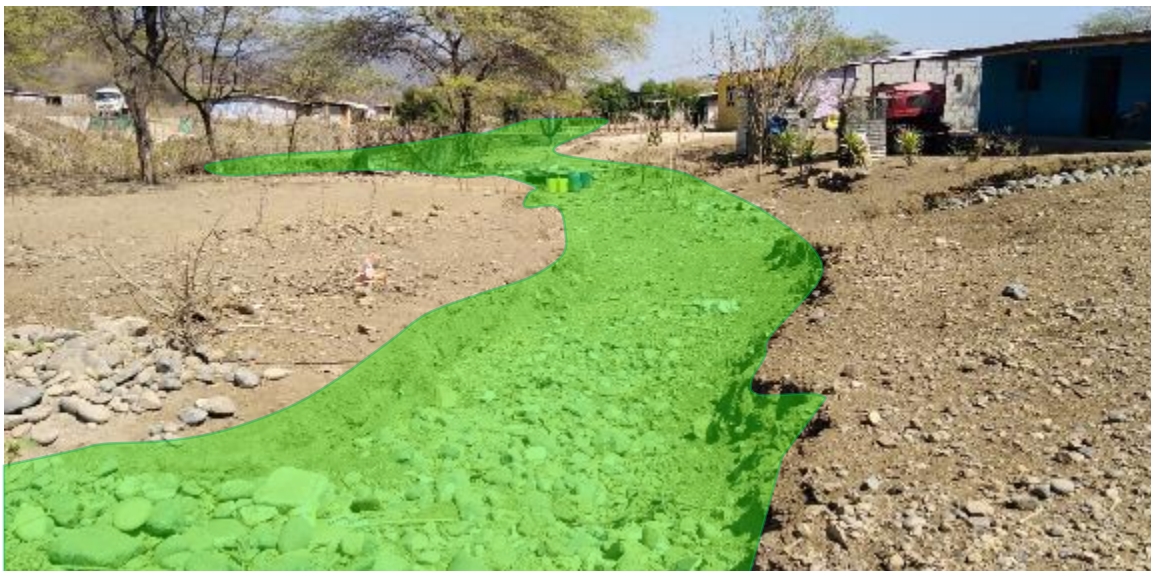
Figura 27. Viviendas del sector San Pedro en ambas márgenes de la zona de erosión por cárcavas.
