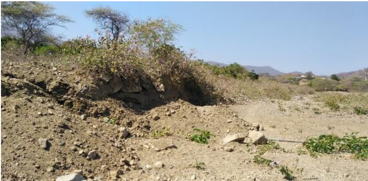
Fotografía 04. Procesos de erosión en la margen derecha de la quebrada El Higuierón
