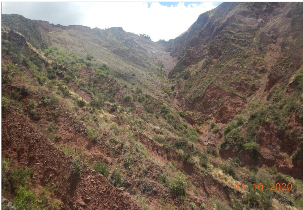
Fotografía 3. Vista al suroeste de depósitos coluviales deluviales, en ambas márgenes de la quebrada Hatunhuayco.
