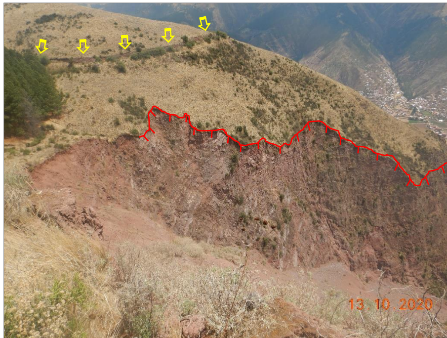
Figura 11. Vista del canal de drenaje revestido (flechas amarillas), en la parte posterior a las zonas de arranque, en la margen izquierda de la quebrada Hatunhuayco.
