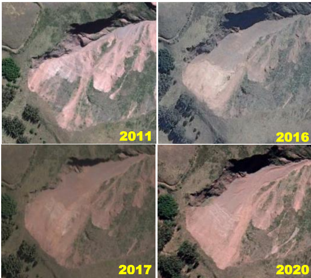
Figura 8. Proceso evolutivo del deslizamiento D1 desde el año 2011, donde se observa claramente la reactivación del deslizamiento el año 2016. Actualmente, el escarpe del deslizamiento presenta 212 m de longitud y muestra actividad retrogresiva.
