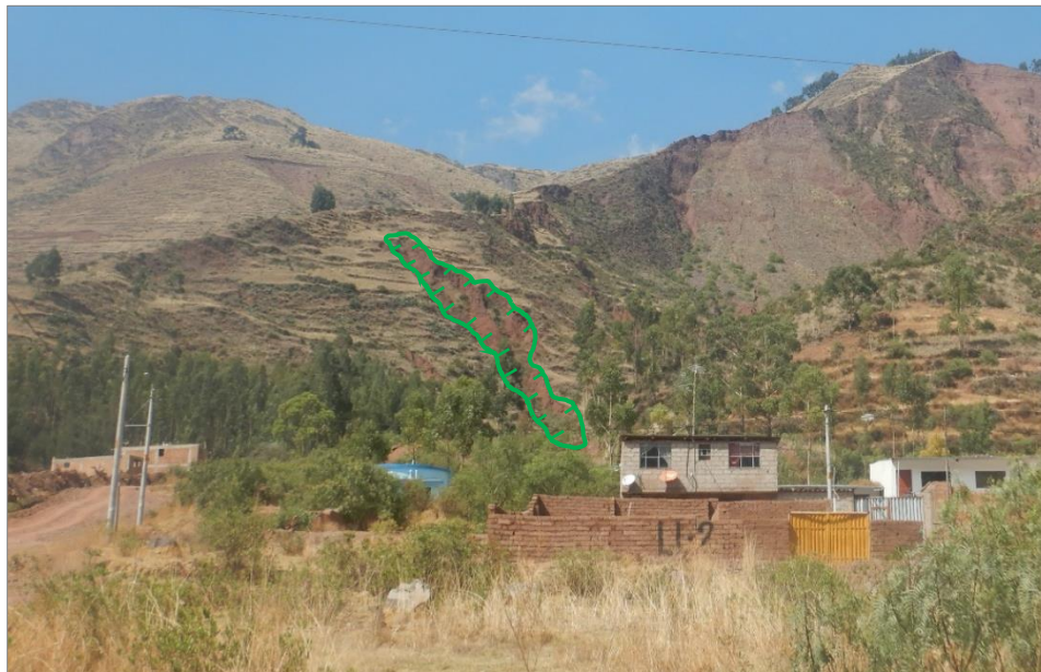
Figura 13. Vista al suroeste de la quebrada Hatunhuayco, con presencia de procesos de erosión de ladera en cárcavas (delimitado en líneas verdes), en la margen derecha de la quebrada referida.
