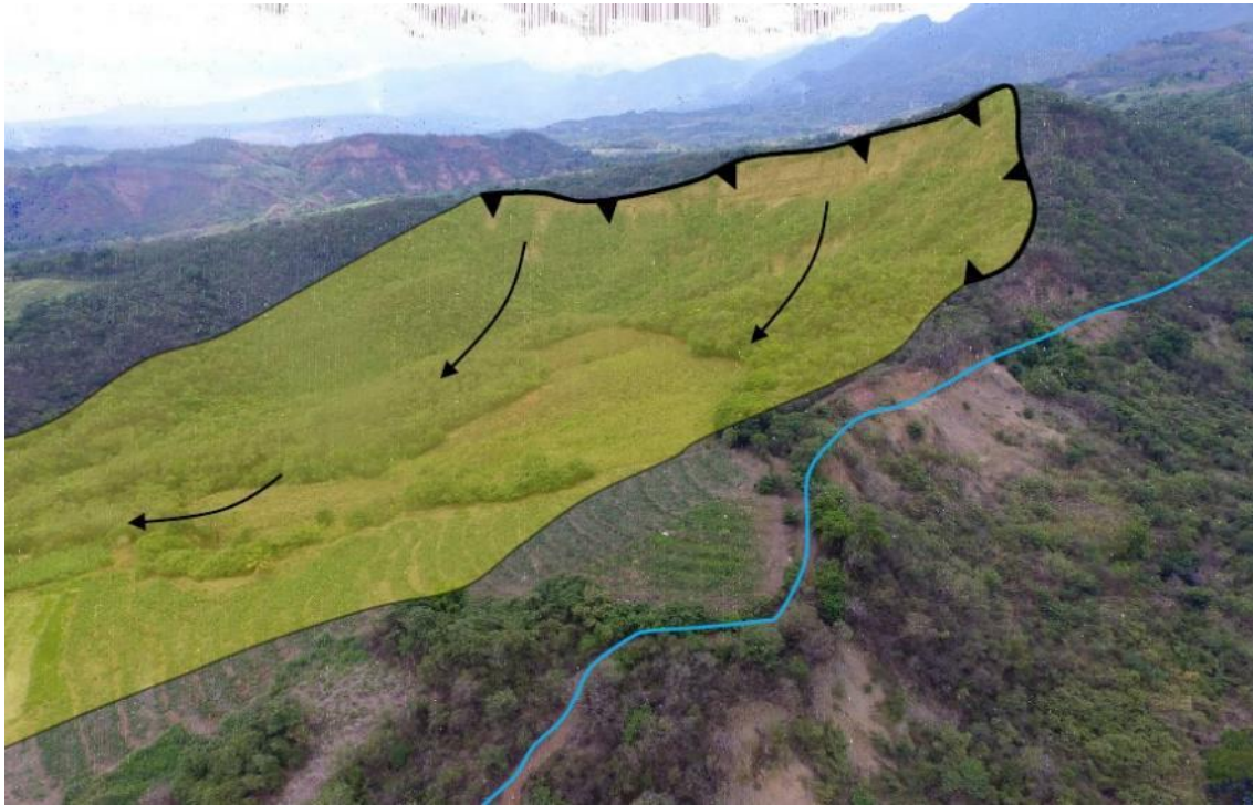
Figura 09. Vista aérea de sur a norte del deslizamiento antiguo 01.
