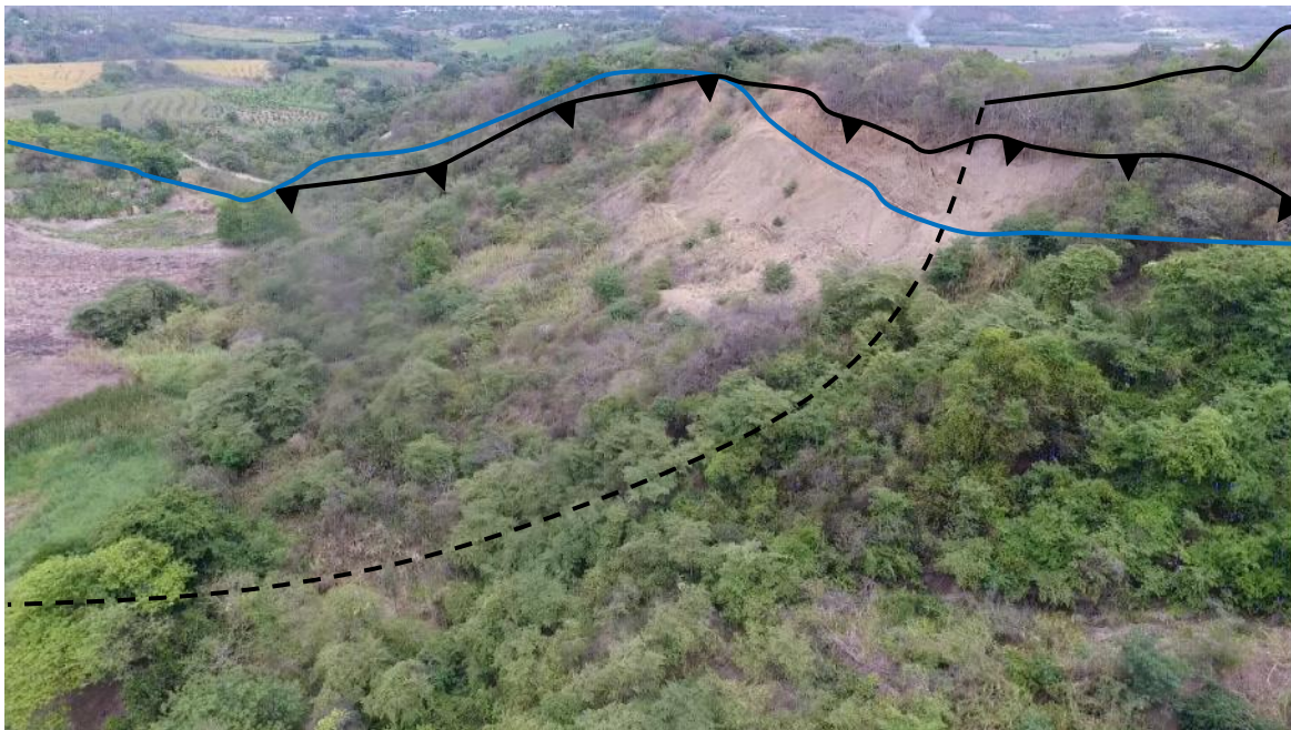
Figura 14. Deslizamiento con plano de falla cóncavo y la acequia El Huingo.
