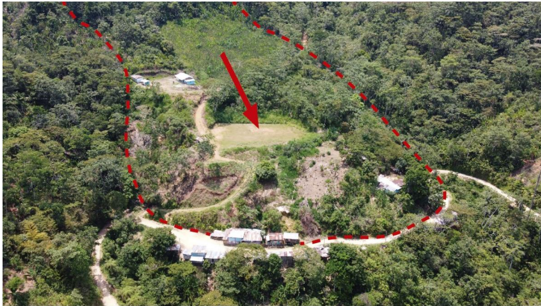
Figura 14. Entre líneas rojas entrecortadas, se muestra el depósito de deslizamiento antiguo, cuya base es cortado por el trazo de carretera propiciando su inestabilidad.
