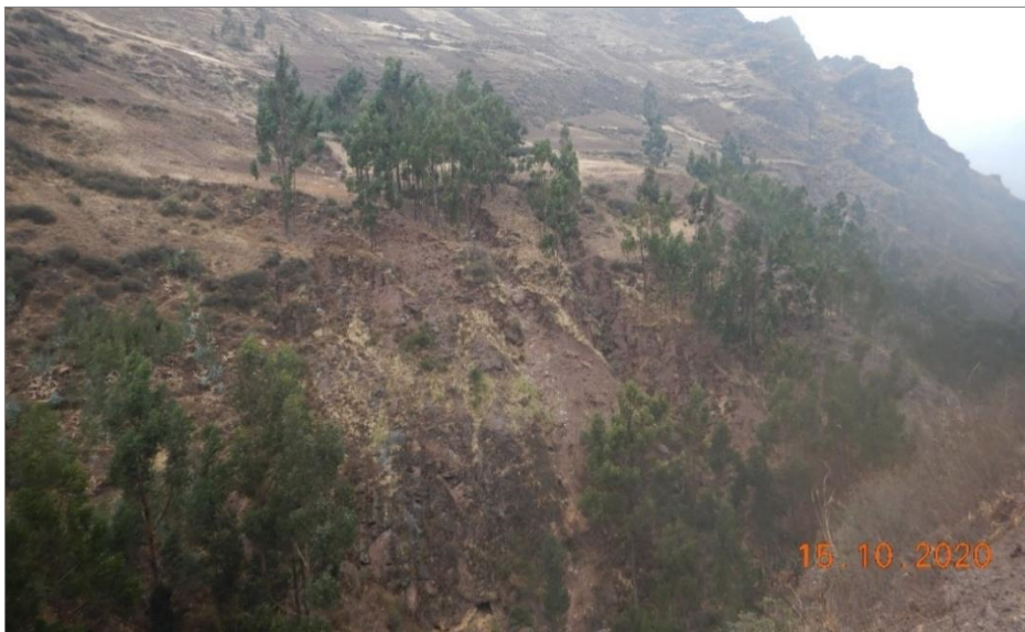
Fotografía 4. Vista de derrumbes en la margen izquierda de la quebrada Chahuay cubierto por vegetación arbustiva.
