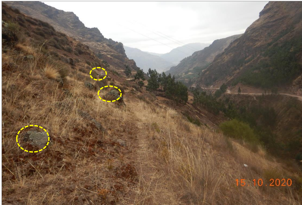
Figura 6. Vista al suroeste depósitos coluviales depositados al pie de la ladera, y margen izquierda de la quebrada Chahuay.
