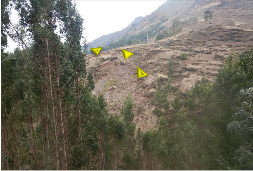
Figura 11. Vista del escarpe del deslizamiento (demarcado con flechas amarillas) detonado el año 2010, actualmente se mantiene activo. Con coordenadas WGS84: 195381 E, 8518079 N, 3476 m s.n.m.
