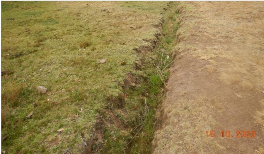
Fotografía 3. Vista del canal de drenaje sin revestimiento en el cuerpo del deslizamiento complejo, en temporada de lluvia, el agua infiltra a lo largo del canal, este podría reactivar deslizamientos y derrumbes.
