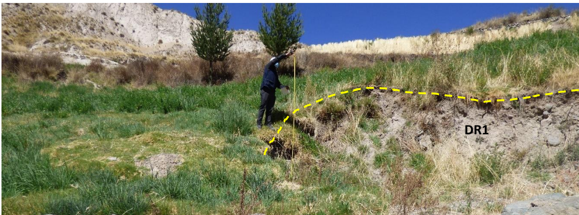
Figura 10. Muestra el deslizamiento reciente DR1, ubicado a un costado de la vía de acceso a Canocota, (coordenadas UTM E: 224852, N 8278414).
