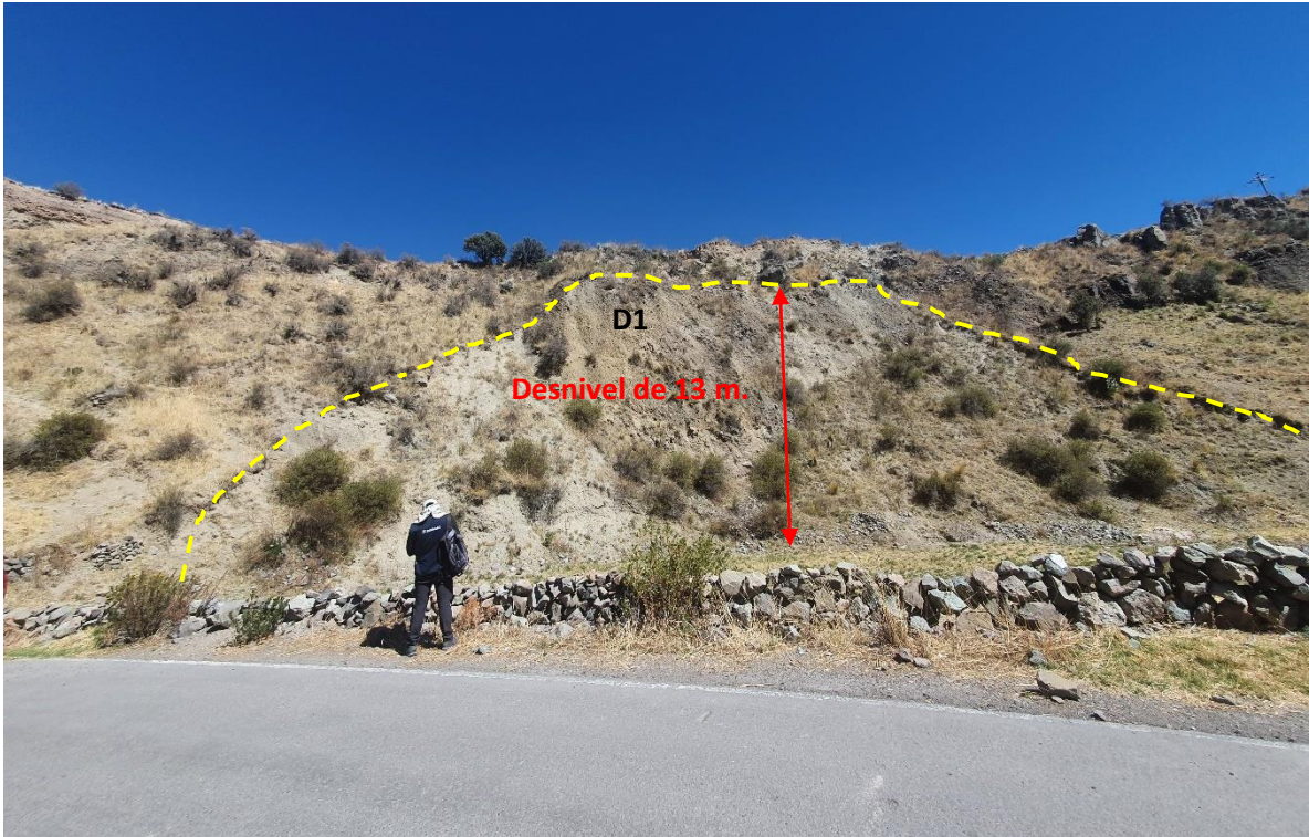
Figura 7. Muestra el deslizamiento antiguo D1 en la vía de acceso a Canocota, (coordenadas UTM E: 225018, N 8278643).
