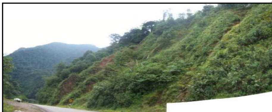
Deslizamiento cerca del caserío El Boquerón. En tiempos de lluvia afecta a la carretera.
