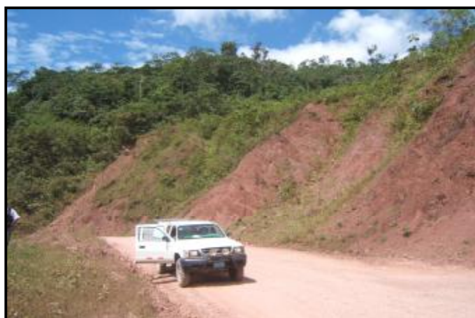
Carretera Divisoria-Aguaytía, Km.46, se presentan deslizamientos de tipo traslacional.
