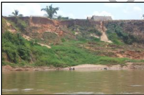
Deslizamiento del sector de Puerto Esperanza
