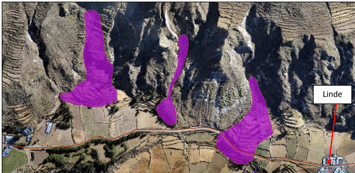
Figura 44. Deslizamientos por flujo en el sector Linde.
