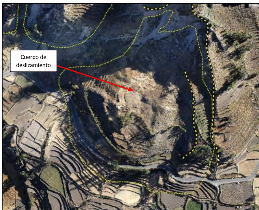
Figura 39. Deslizamiento representativo en el sector de Linde, (coordenadas UTM E: 208562, N: 8268333).
