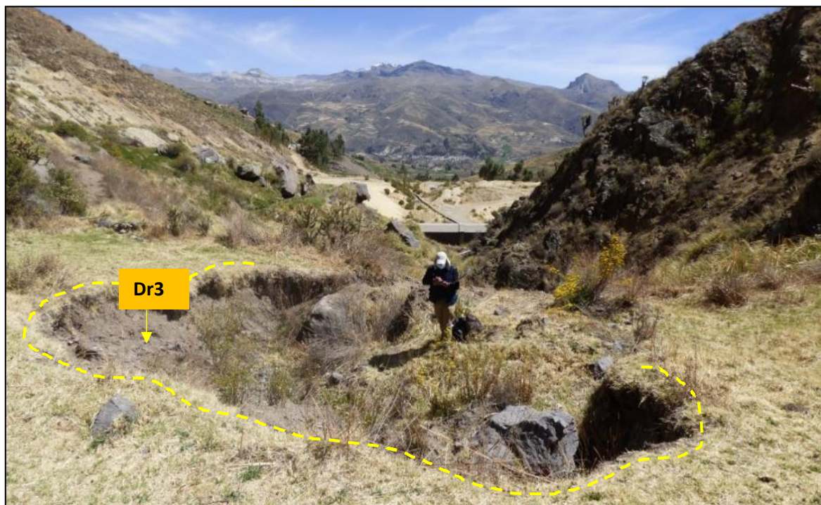
Figura 12. Escarpe de deslizamiento reciente Dr3 en el sector Collpane, (coordenadas UTM E: 211378, N: 8263890).
