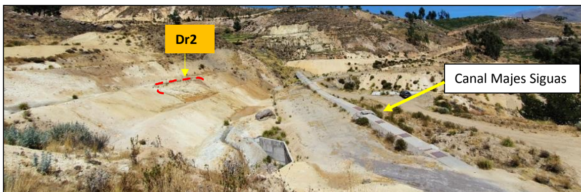
Figura 11. Escarpe de deslizamiento reciente Dr2 en el sector Collpane.
