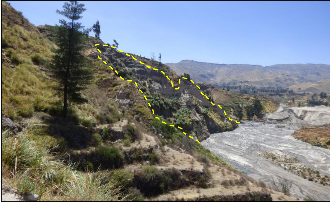
Figura 33. Zona de derrumbes en el sector Urinsaya (coordenadas UTM E: 211806, N 8267653).
