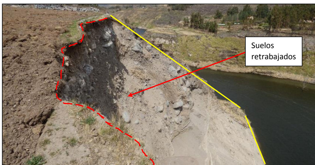
Figura 24. Pendiente de los escarpes que varían entre 45° a 70°, (coordenadas UTM E: 212639, N: 8266820).
