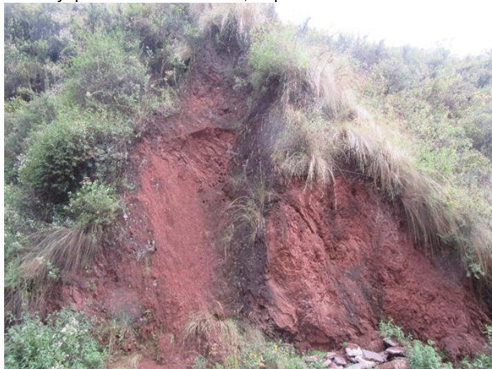
Fotografía: Depósitos residuales supra yaciendo a los afloramientos rocosos de areniscas fracturadas, Con ubicación E 175879 N 8505177. Fuente: Equipo Técnico PM41ZRE.
