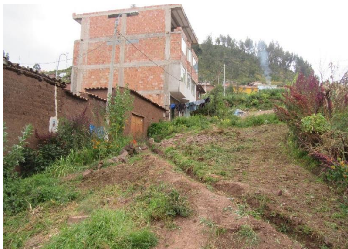
Fotografía: Vista de la ladera con pendiente empinada donde se encuentra viviendas de la manzana B', ubicación E 175184 N 8505187. Fuente: Equipo Técnico PM41ZRE
