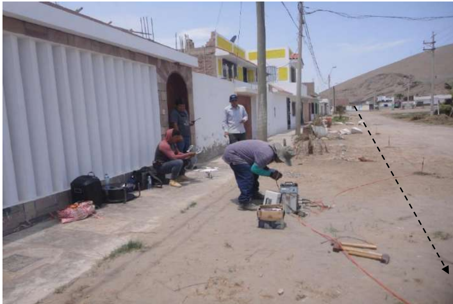
Fotografía 4.5: Muestra el alineamiento de la línea LT-5 de forma paralela a la línea de costa, se realizó un perfil de una longitud de 230 metros.
