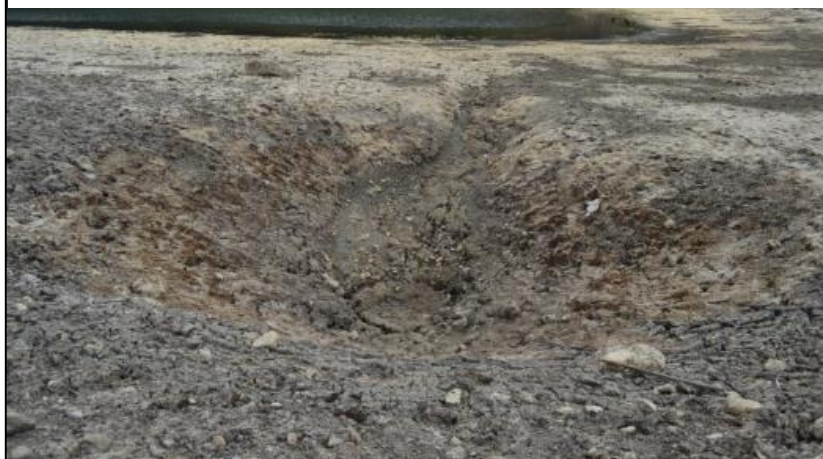
Fotografía N° 20: Uspaqocha desagua por filtraciones que están ubicadas en la zona frontal y lateral derecha del lecho lagunar, se evidencia las zonas de depresión por donde el agua se infiltra.
