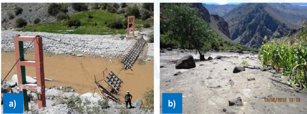
Figura 25.- a) Puente peatonal de ~50 m de largo destruido durante el desembalse de la laguna formada en el río Tambo el día 13 de febrero de 2016; b) Terrenos de cultivo destruidos por el lahar del 12 de febrero en el sector de Huarina, cerca de la confluencia de los ríos Ubinas y Anascapa.
