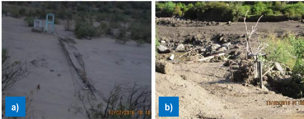
Figura 23.- a) Destrucción del puente peatonal “Ánima” (Huarina), originado por el lahar del día 12 de febrero 2016 en el río Para; b) Destrucción de canales de agua en el sector de Huatagua
