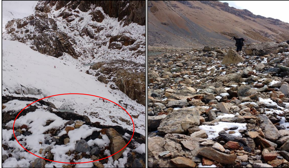
Fotografía N° 03: Rocas sueltas que pueden provocar eventuales deslizamientos.
