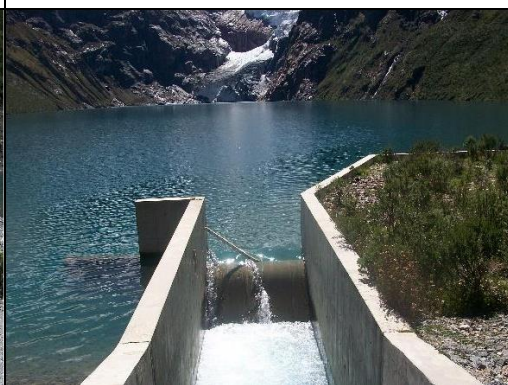
Fotografía N° 16.- Parte del tramo inicial del aliviadero-vertedero.
