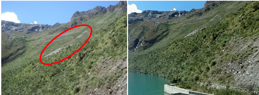
Fotografía N° 28.- En esta vista se observa material morrénico con buena estabilidad, protegido por cobertura vegetal, donde sobresalen pequeños depósitos coluviales en las laderas con muy baja estabilidad (vista izquierda). Inestabilidad del talud en la boquilla originada por las lluvias estacionales (vista derecha).
