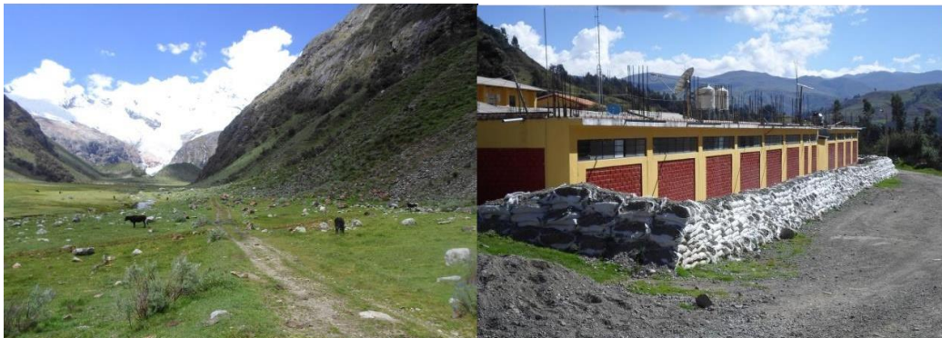
Fotografía N° 24.- Izquierda, vista panorámica de la parte alta de la quebrada Pariac, con bajas pendientes y abundante presencia de bofedales; a la derecha, Colegio principal en la localidad de Macashca, protegido por sacos de arena ante un posible desborde de la laguna Rajucolta.
