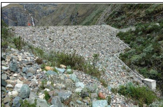
Fotografía N° 13.- Vista del talud aguas abajo o cara exterior de la presa.
