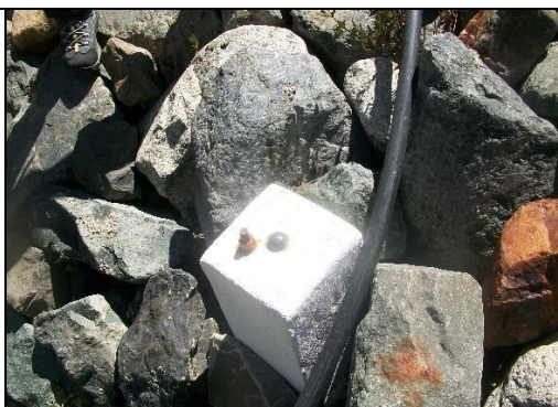
Fotografía N° 20.- Punto de nivelación o asentamiento, ubicado en el talud aguas abajo de la presa.
