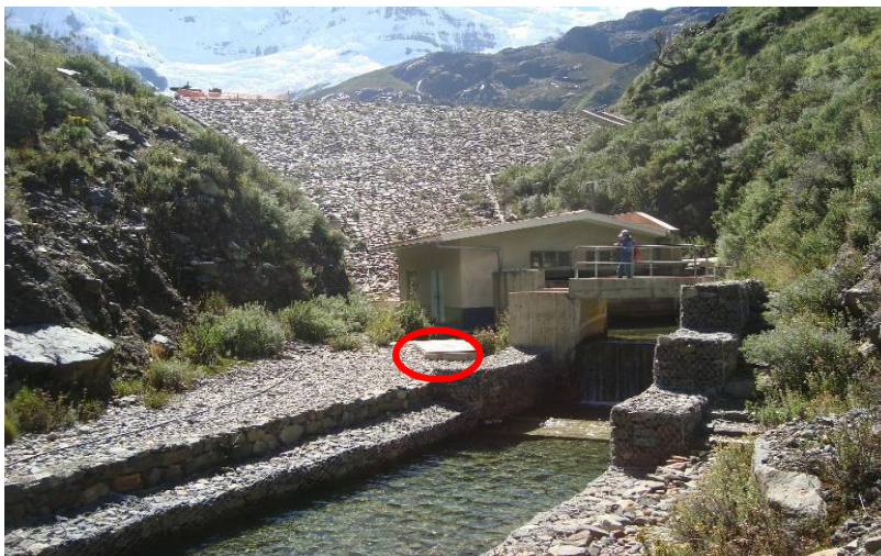
Fotografía N° 29.- En la vista se observa las características físicas de la presa, la casa de válvula, vertedero con su respectivo canal y un vertedero para medir el caudal de filtración (círculo rojo).
