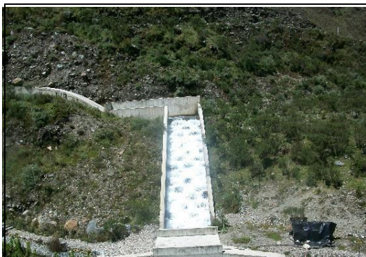
Fotografía N° 17.- Vista del aliviadero (rápida).
