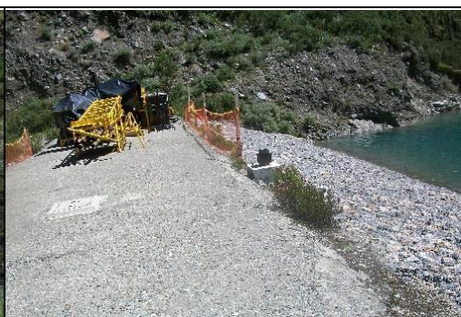
Fotografía N° 14.- Vista del talud aguas arriba o cara interior de la presa.
