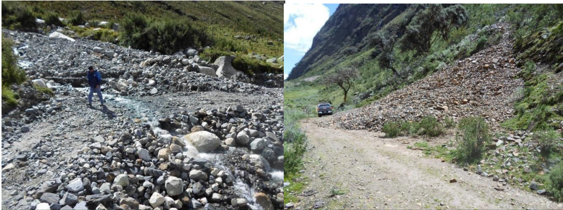
Fotografía N° 04.- Procesos de origen hídrico y gravitacional en diferentes sectores de la quebrada Pariac. Se observa torrentes estacionales que se reactivan durante las lluvias interrumpiendo temporalmente el acceso a la laguna Rajucolta.
