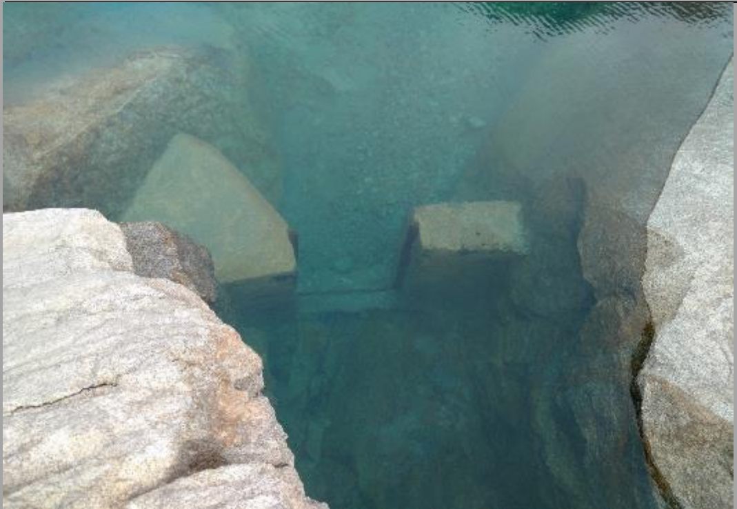
Fotografía N° 02: Vista de los pilares que contienen las guías de las ataguías del canal de entrada.
