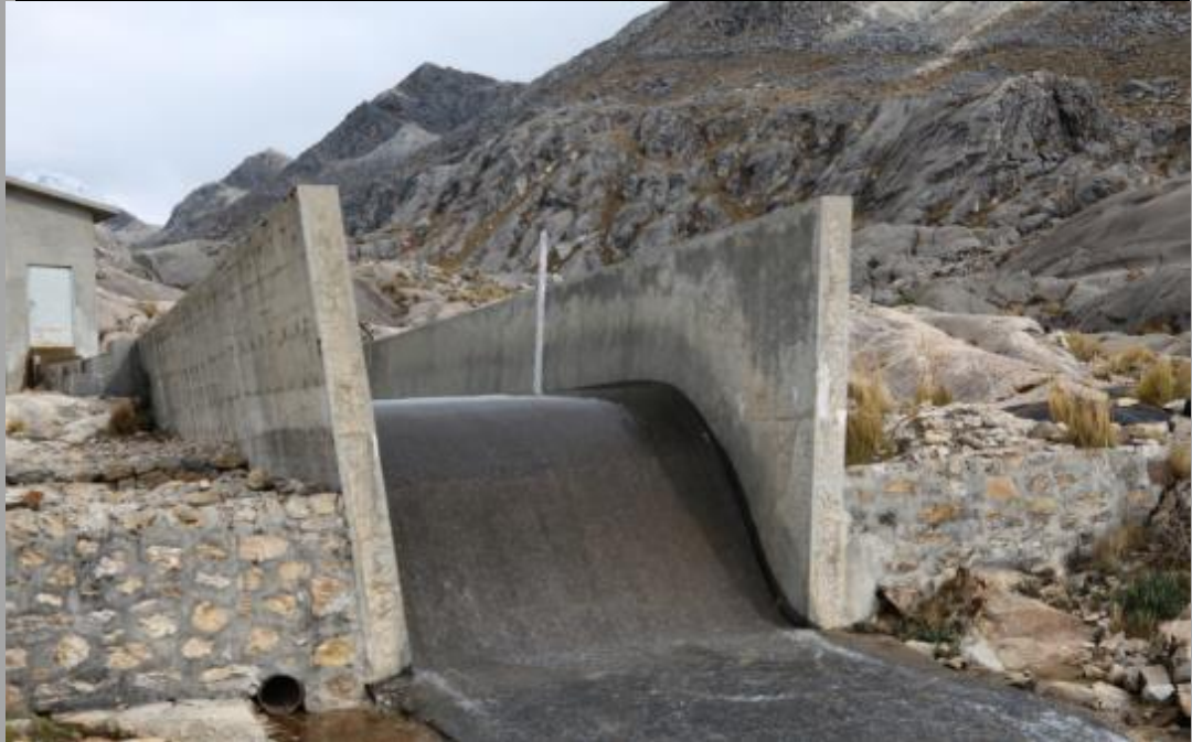
Fotografía N° 10: Vista del azud vertedero tipo Creager ubicada en el tramo final del canal de salida, que controla el caudal de salida del embalse de la laguna Cullicocha.
