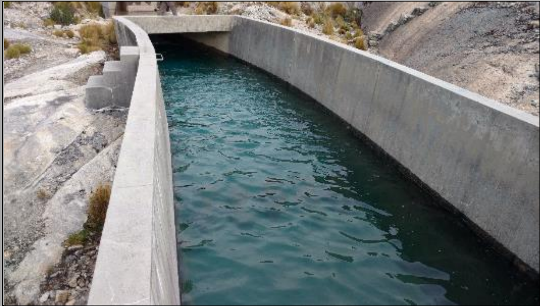
Fotografía N° 08: Vista del canal de salida.
