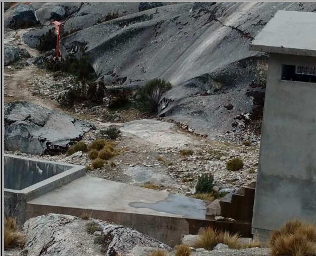
Fotografía N° 07: Vista de la plataforma que cubre a la estructura de impacto.
