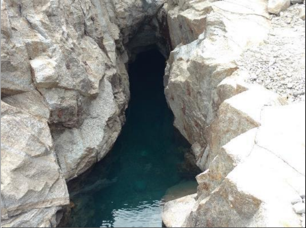
Fotografía N° 04: Vista de la entrada del túnel de aducción.
