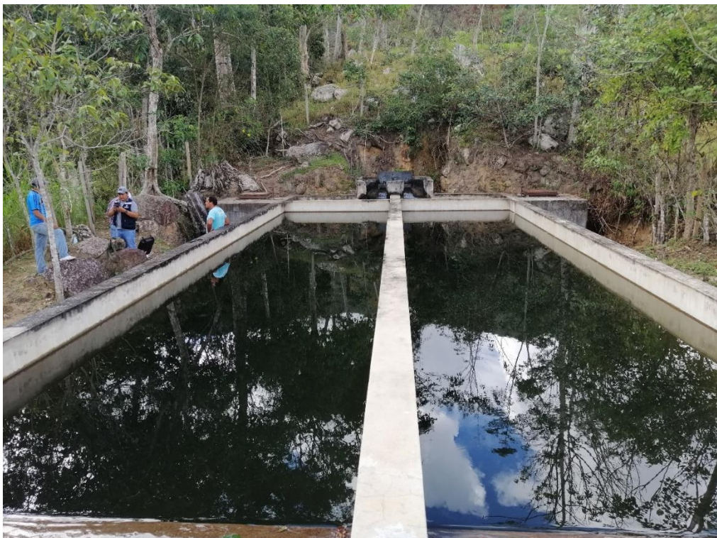
Fotografía 12. Reservorio del sistema de agua potable del C.P Shucshuyacu.
