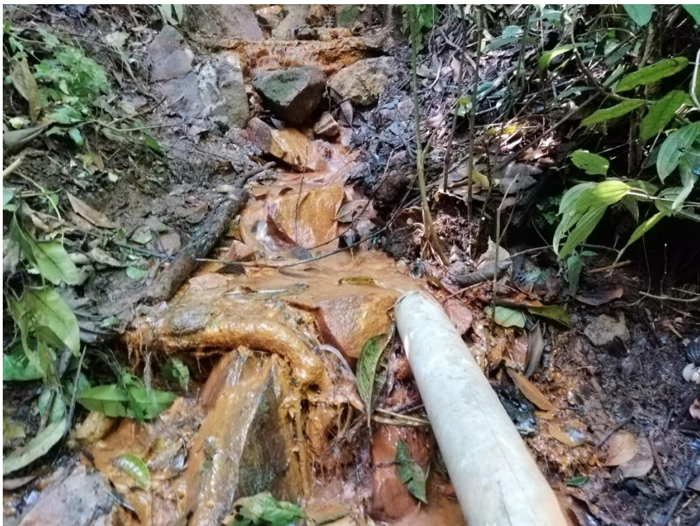
Fotografía 10. Presencia de sedimentos color anaranjado en el cauce de la quebrada Tioyacu Margen Derecha.
