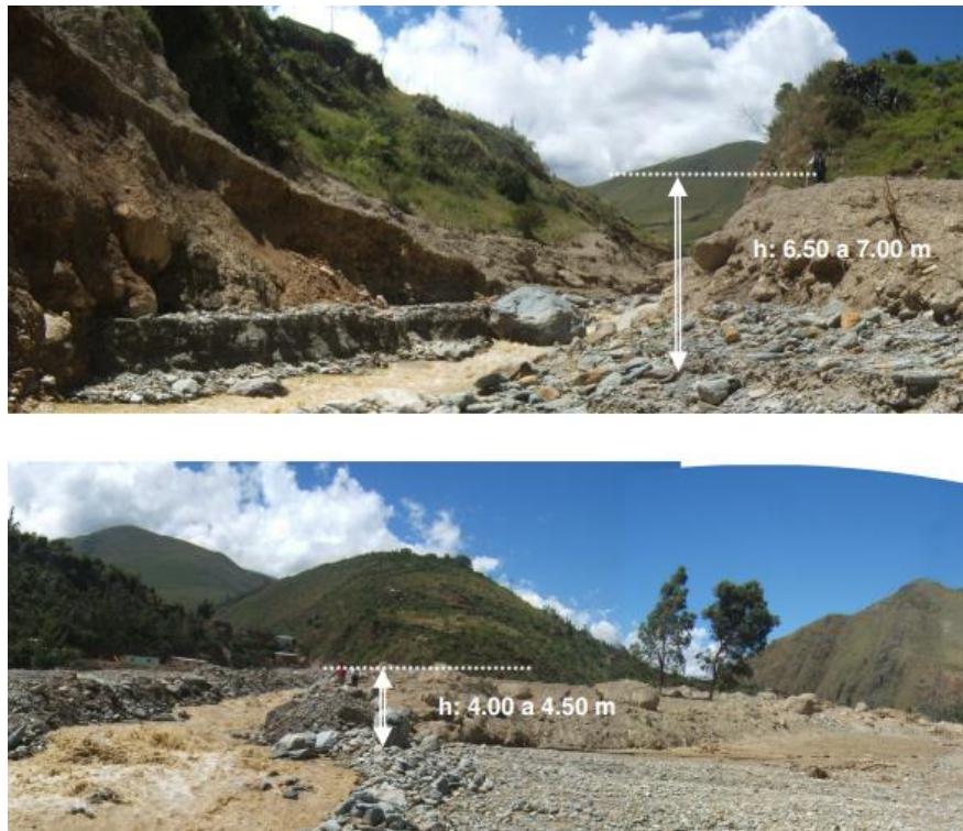
Figura 03. Altura del flujo en el inicio de apertura del abanico proluvial en 16 de Noviembre (vista superior), así como en la parte frontal - terminal, respecto al cauce erosionado de la quebrada (vista inferior). Tomada del Informe Técnico N° A6529.
