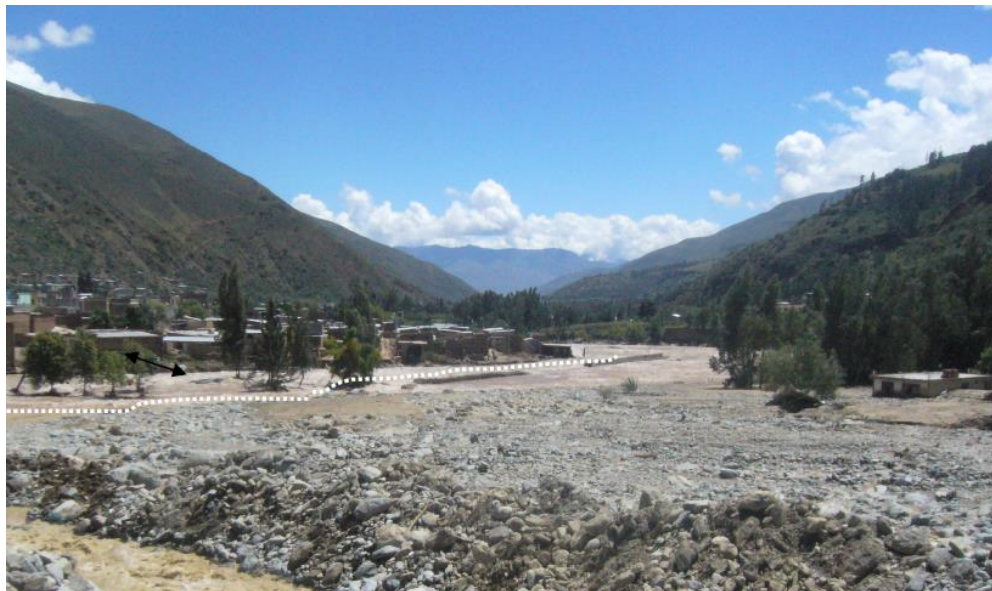
Figura 04. Vista aguas abajo del río Huallaga. La línea punteada muestra la margen izquierda antes del aluvión, que correspondía a un muro de gavión y terraza la cual ha sido erosionada e inundada. Tomada del Informe Técnico N° A6529.
