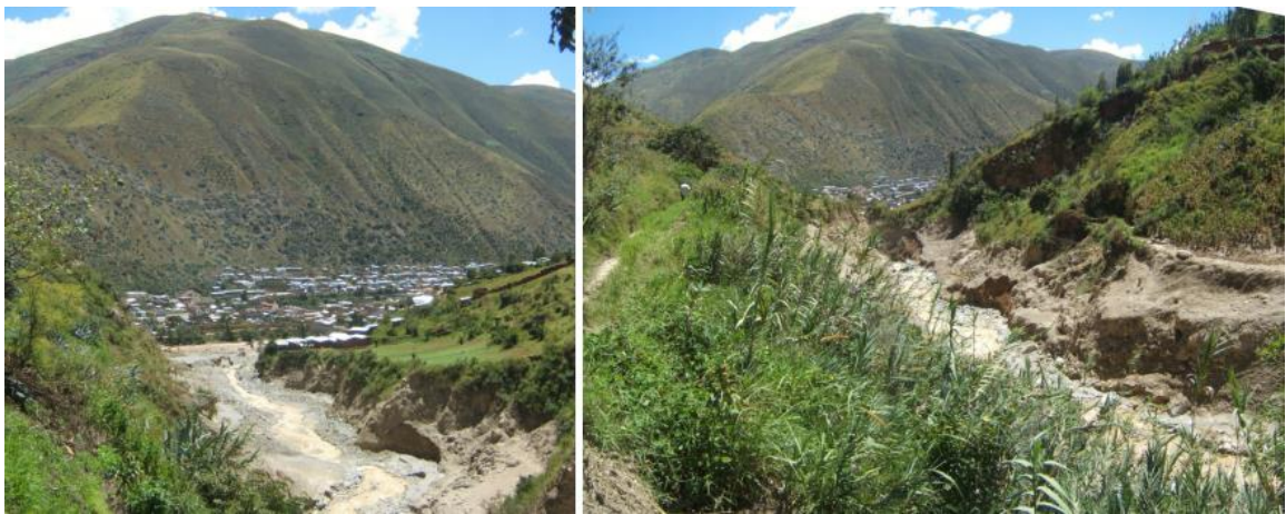
Fotografía 04. Alturas alcanzadas por el lodo del huayco en el tramo final adosadas en las márgenes de la quebrada Arroyo 1. Nótese la pendiente del cauce. Tomada del Informe Técnico N° A6529.
