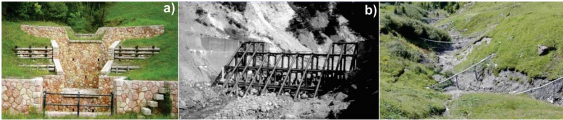
Figura 02. Presas de sedimentación escalonada para controlar la fuerza destructiva de los huaicos: (a) tipo SABO, (b) tipo rejilla, (c) barras flexibles.
