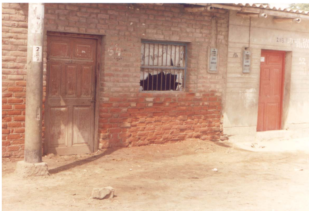
Ataque de sales en materiales de construcción Calle Comercio – Sector Monte Sullón
