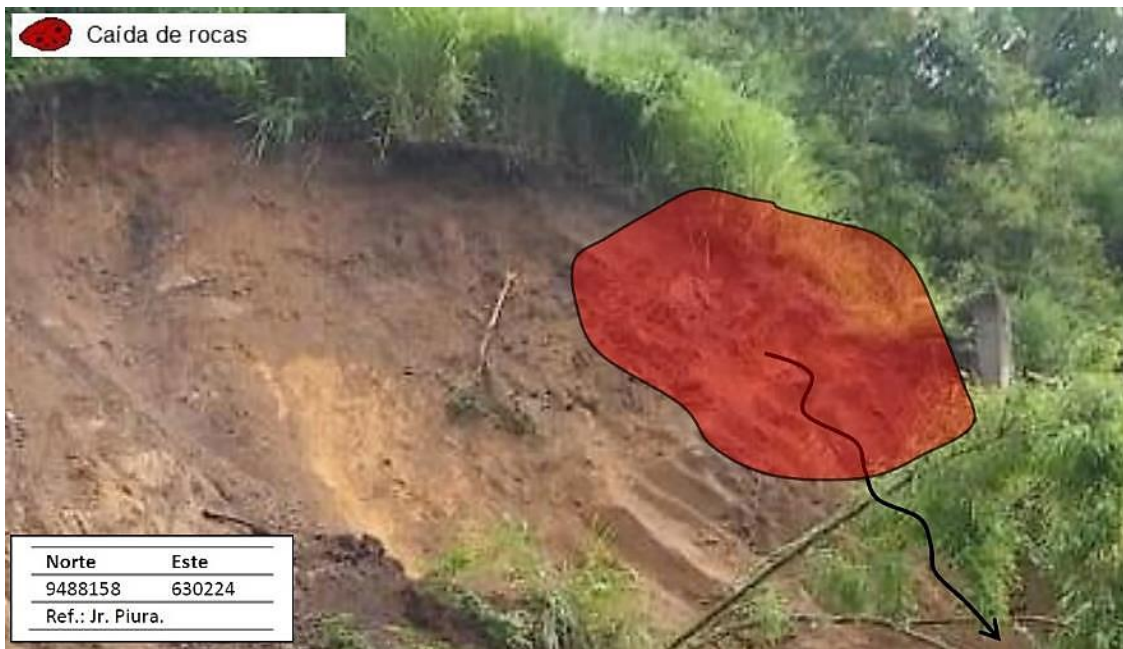
Figura 26. Zona de caídas de rocas y suelos en el Jr. Piura.
