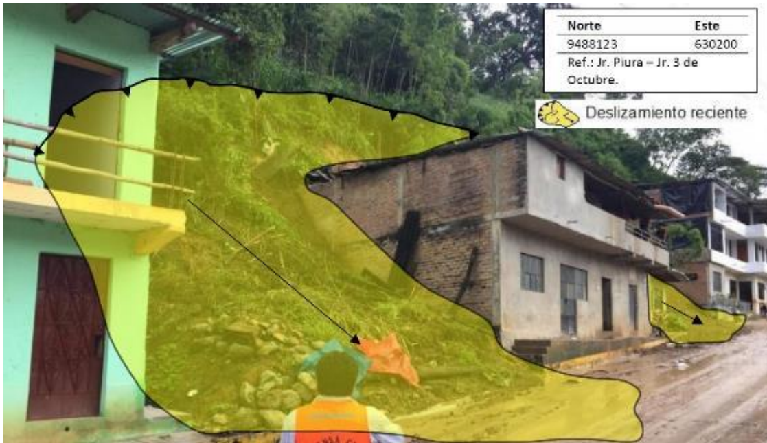
Figura 18. Viviendas de la calle Piura afectadas por la caída de los materiales provenientes del deslizamiento DR-01.
