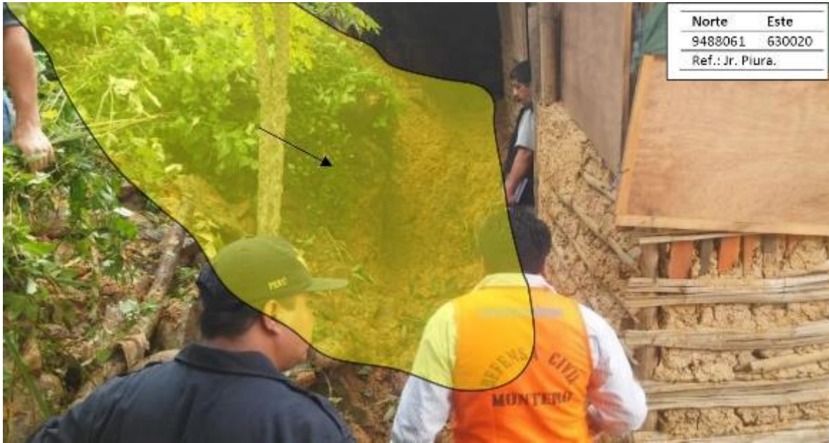
Figura 38. Materiales deslizados ingresaron a la vivienda de material rústico.
