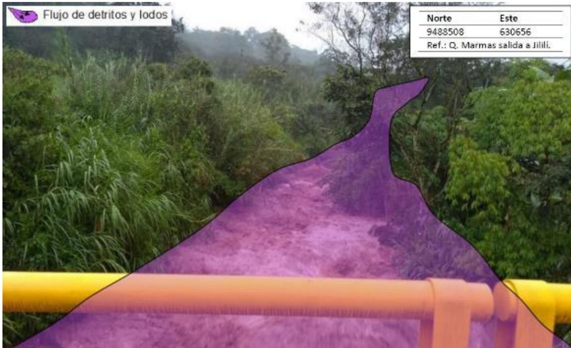
Figura 24. Quebrada Marmas en la crecida del mes de marzo del 2017.
