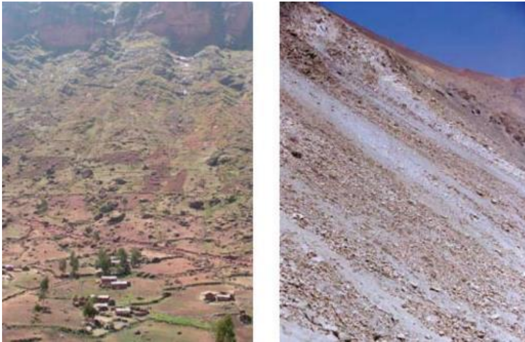
Figura 44. Caída de rocas (a) Comunidad Chullpa Khasa, Provincia de Ayopaya, Departamento de Cochabamba, Bolivia (Fotografía G. Quenta) (b) Margen izquierda del río Huaura, provincia de Oyon, Lima, Perú (Fotografía L. Fidel).
