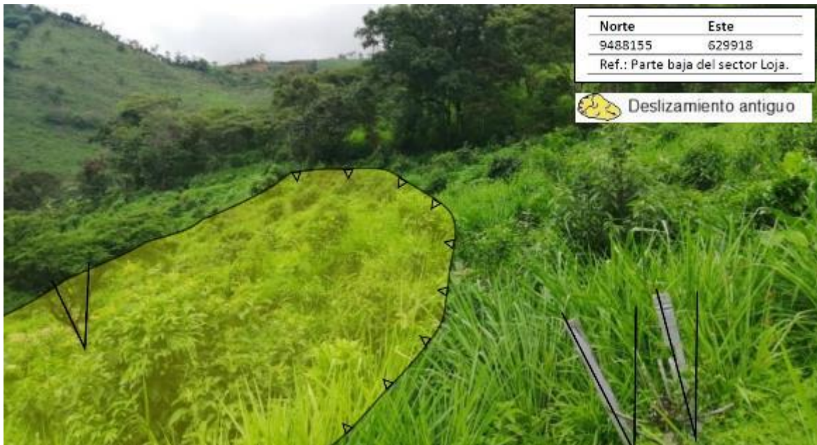
Figura 13. Deslizamiento antiguo 02 próximo al área urbana de Montero.
