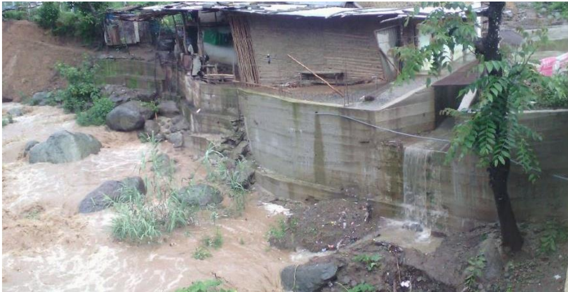
Fotografía 01. Andesitas sobre las que se asientan los muros de contención en la margen derecha de la quebrada Marmas, coordenadas: 9488136N, 630465E.
