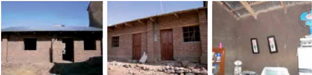
Viviendas tartajeadas y acabadas
