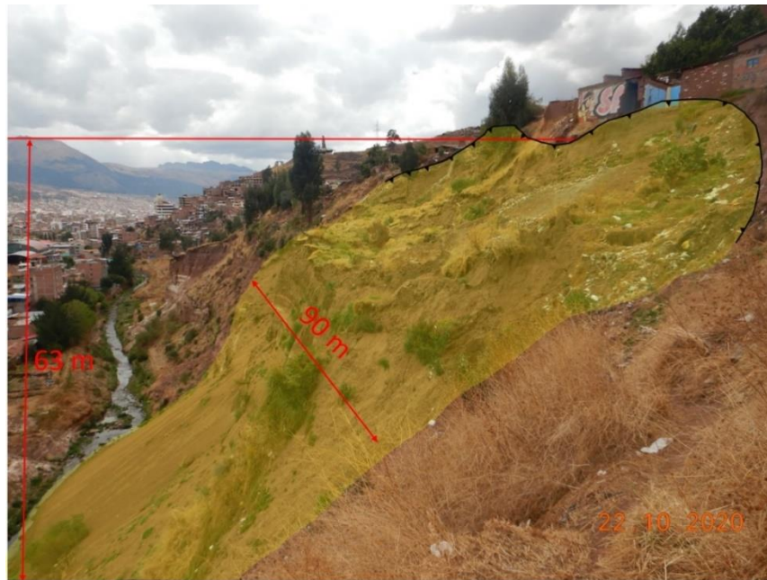
Figura 11. Vista tomada en coordenadas UTM (GWS184-Zona 19s) E 178080; N 8501707. Se aprecia el cuerpo del deslizamiento (ancho) y la altura desde la corona hasta el pie del deslizamiento con sus medidas respectivas en la parte baja el cauce del río Huancaro.
