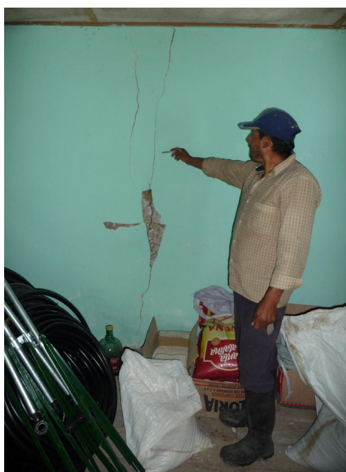
Foto N° 13. Rajadura en la pared de una de las viviendas de Ocopa.
