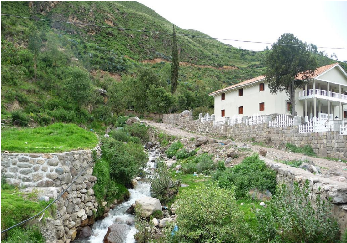
Foto N° 17. Cauce actual de la quebrada Poncoshuyjo, rellena de rocas. Sector Ocopa.
