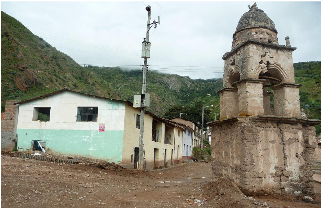
Foto N° 20: Depósitos de flujos recientes que afectaron a las viviendas del poblado de Antaparco.
