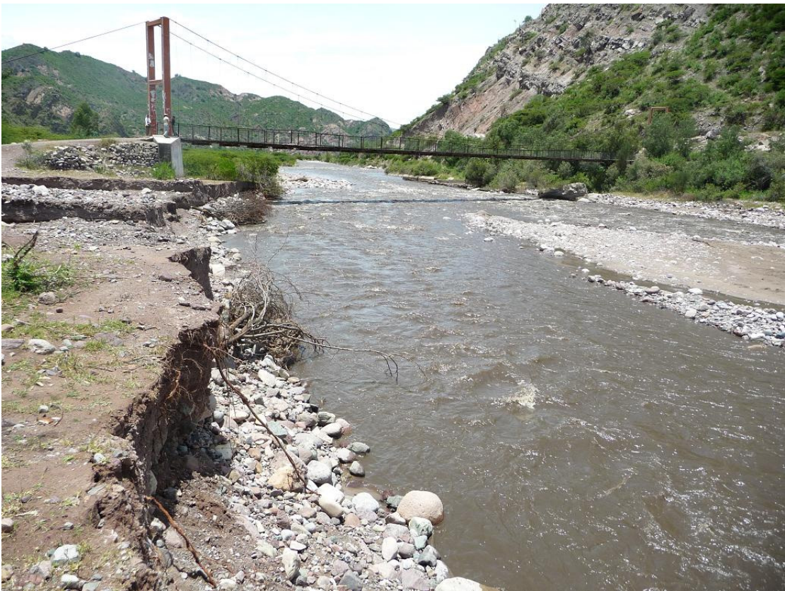
Foto N° 25: Erosión fluvial en la margen izquierda del río Cachi.
