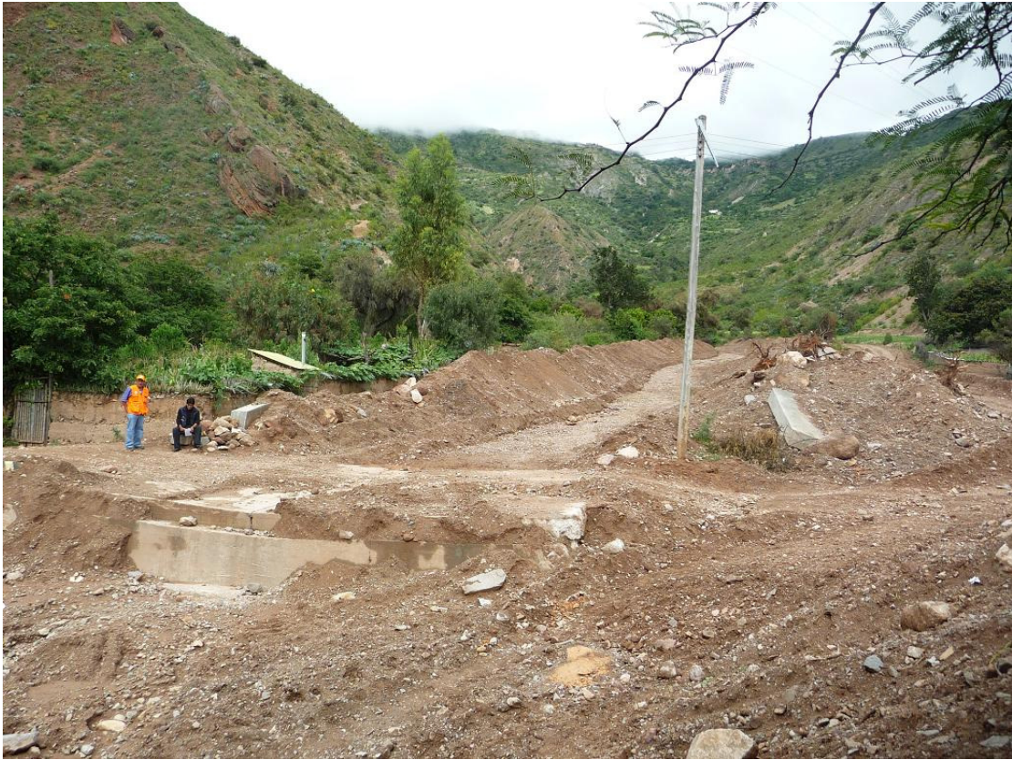
Foto N° 19 b): Cauce actual de la quebrada Ñahuinhuycco.
