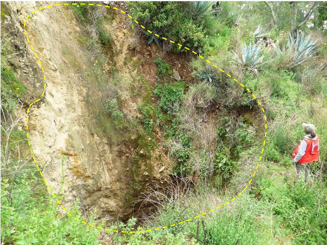
Foto N° 4. Hundimiento activo ubicado en la margen izquierda de la quebrada Piscopampa. Profundidad aproximada de 15 m y diámetro promedio de 7 m.
