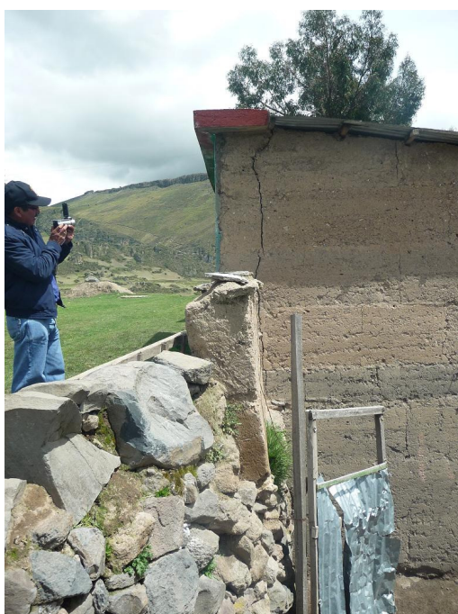
Foto N° 13. Rajadura en la pared de una de las viviendas de Ocopa.
