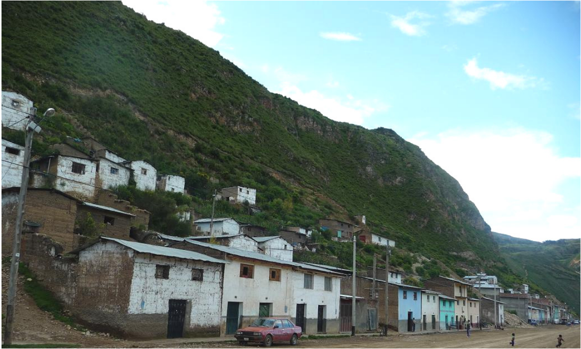
Foto N° 7. Viviendas del barrio Bellavista, ubicado en la falda del cerro Huanchuco, construidas sobre depósitos de caídas de detritos.
