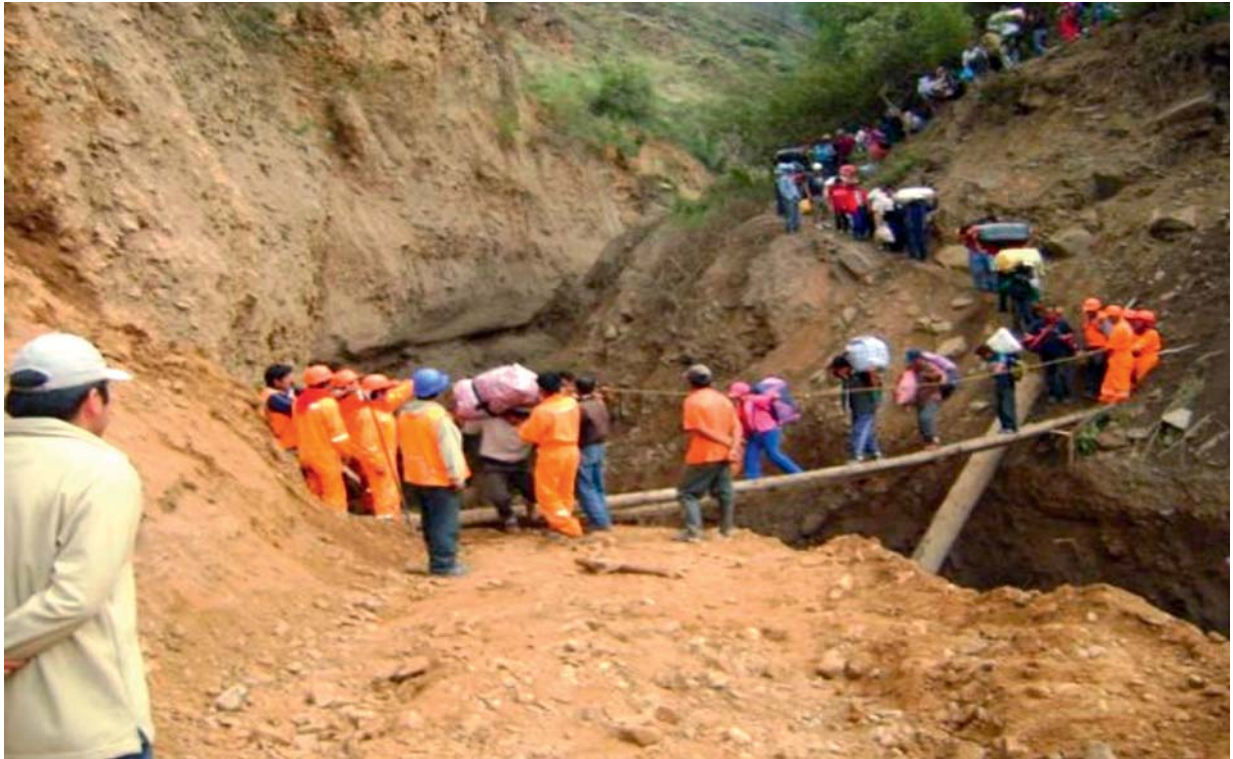
Puente peatonal provisional para realizar transbordo, por el desborde del río Suchiman, departamento de Ancash, 2009.
