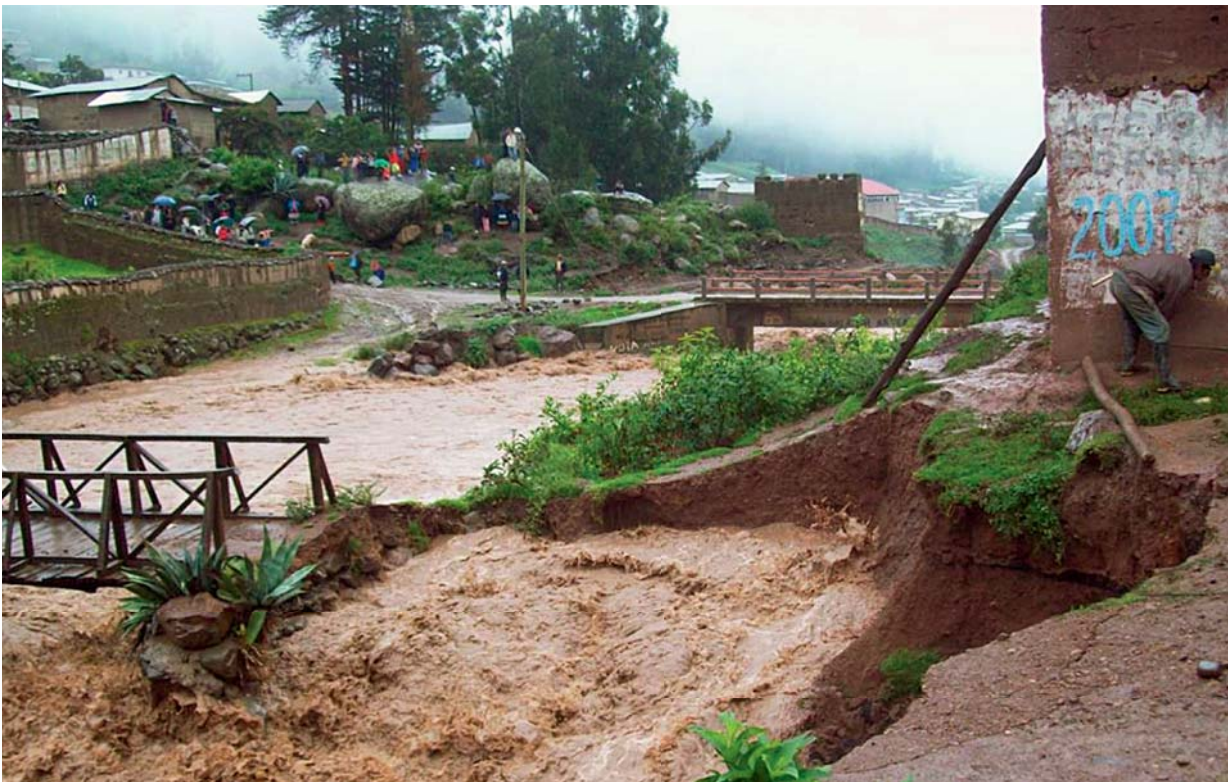
Desborde del río Huacrachuco, departamento de Huánuco, marzo 2009.
