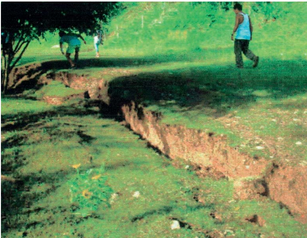
Fotos 4: Agrietamiento del terreno, en el sector de Shamboyacu
