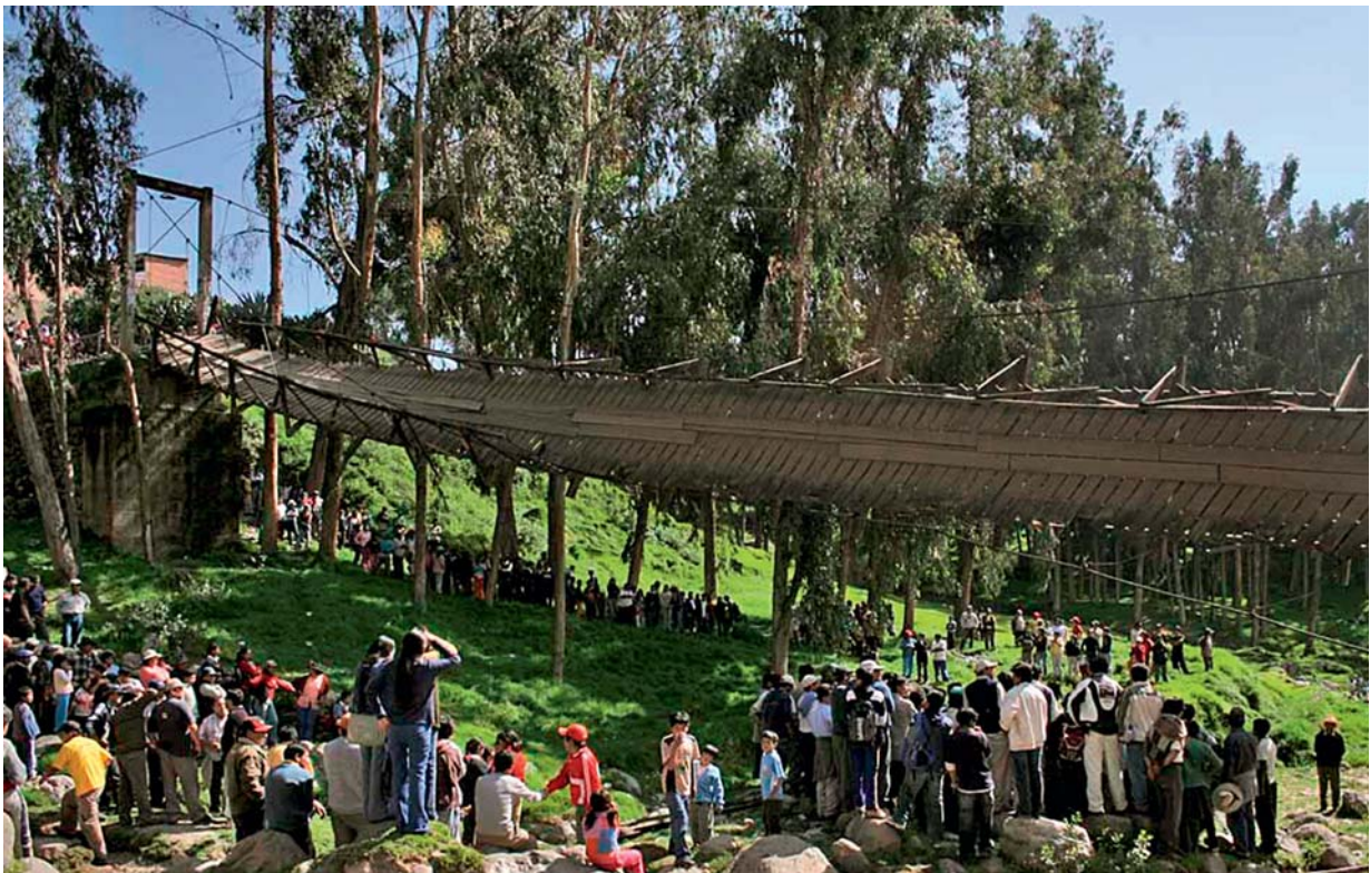
Caída del puente Coracora en el Departamento de Ayacucho, marzo 2009.
