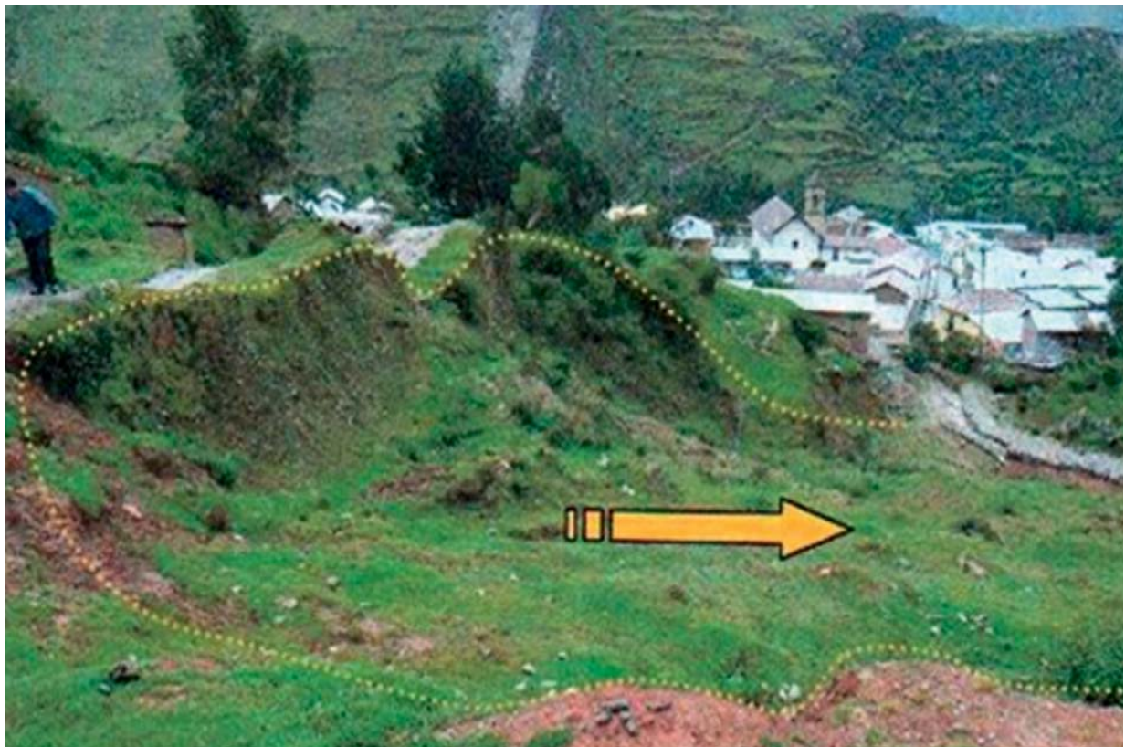
Reptación de suelos activo en la margen izquierda del cauce de la quebrada Huachanagra. La reptación de suelo se produce en el cuerpo de un deslizamiento antiguo
