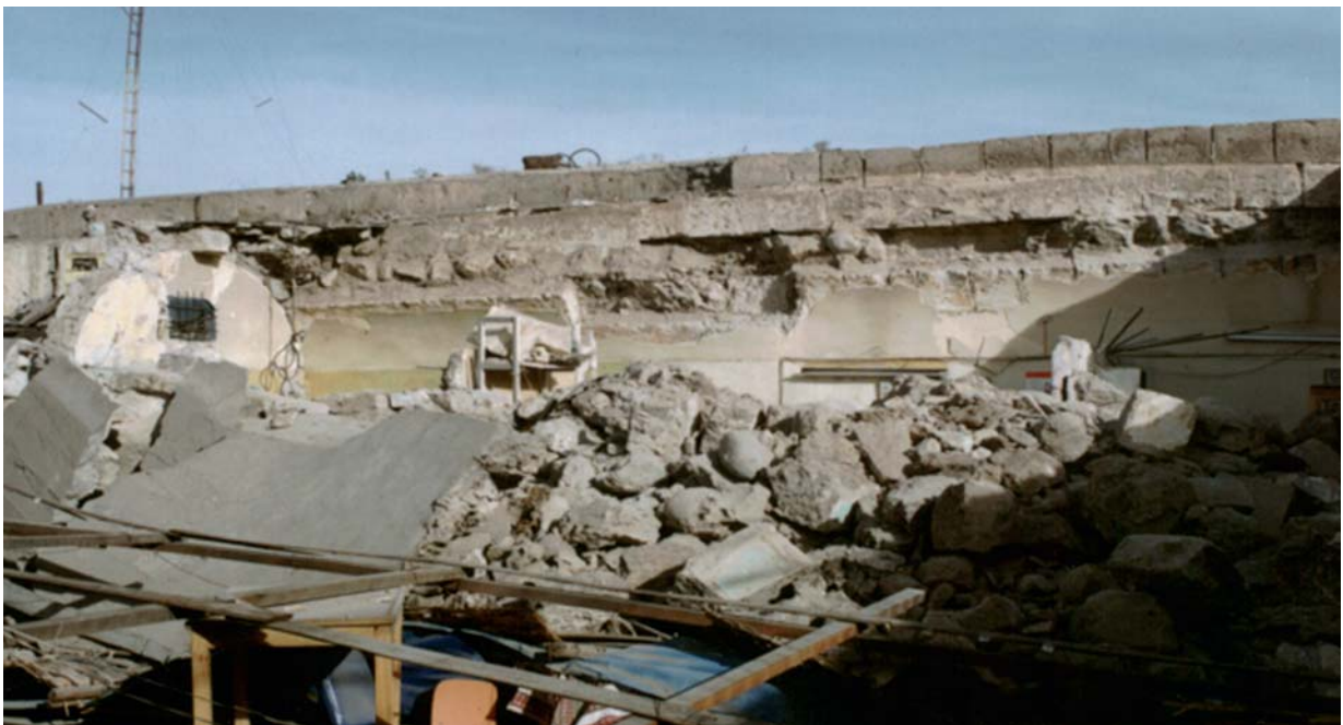
Colapso de vivienda en la tercera cuadra de la calle Peral-Arequipa 2001
