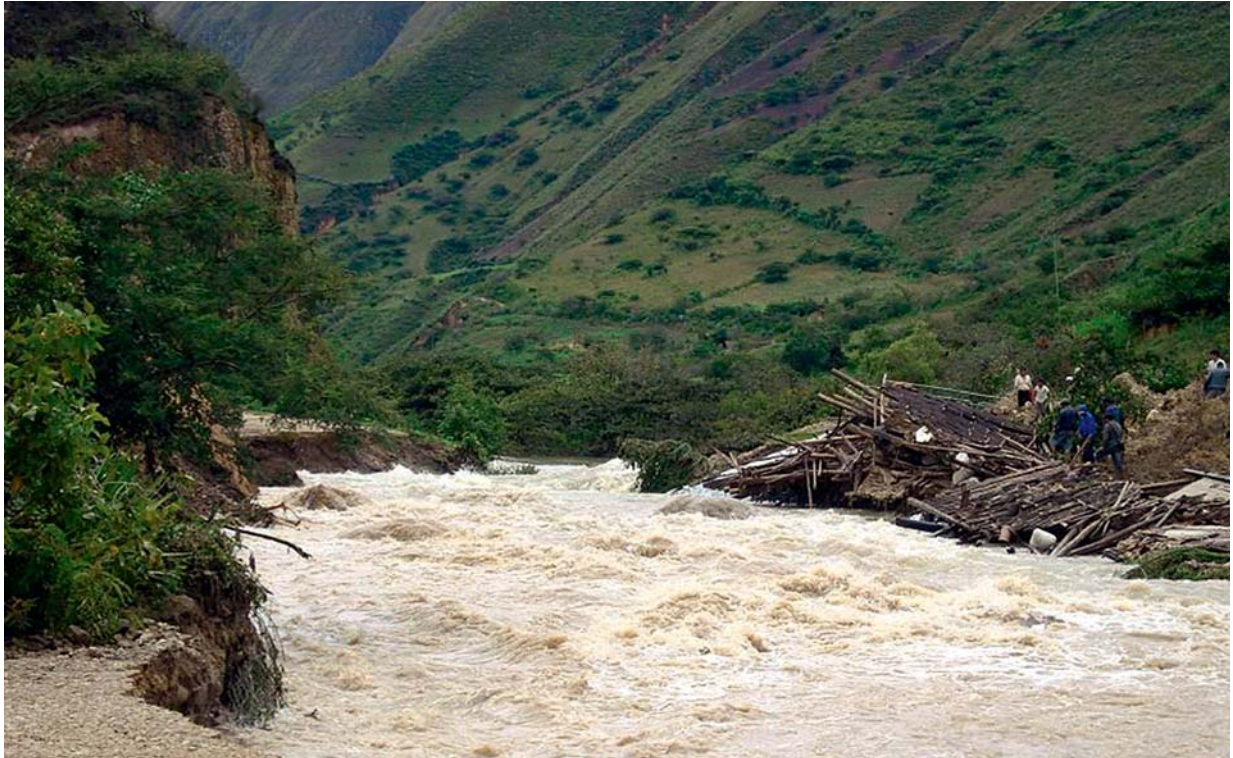
Crecida del río Las Yangas, provincia de Celendín, departamento de Cajamarca, marzo 2009.
