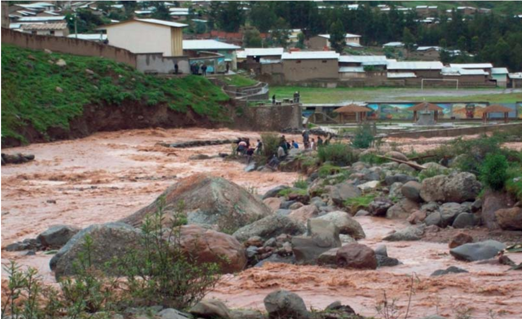
Viviendas destruidas por el deslizamiento
