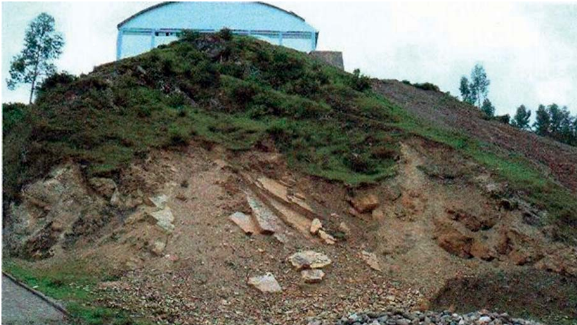
Rocas sedimentarias muy meteorizadas, afloran a pocos metros del puente Huancapucro, margen derecha del río Ticlacayán. Sobre estas se construyó el coliseo de la Municipalidad.
