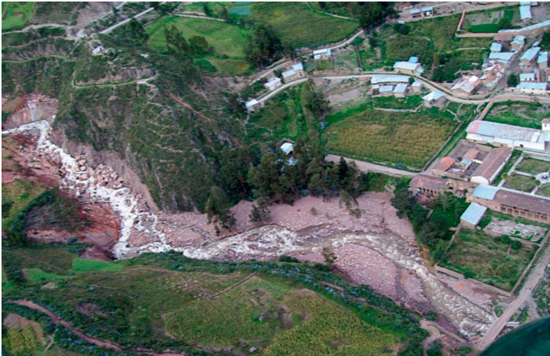
Zonas adyacentes del río donde fueron destruidas las viviendas
