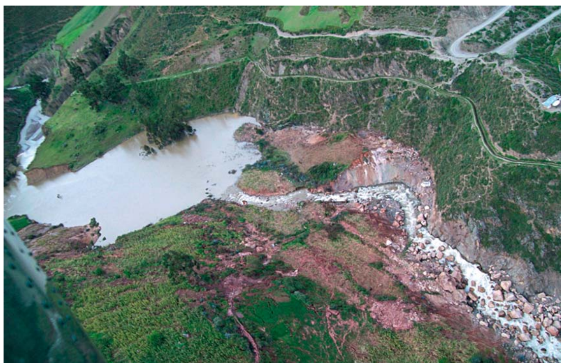
Canal de drenaje de la laguna, que discurre por el mismo cauce del río
