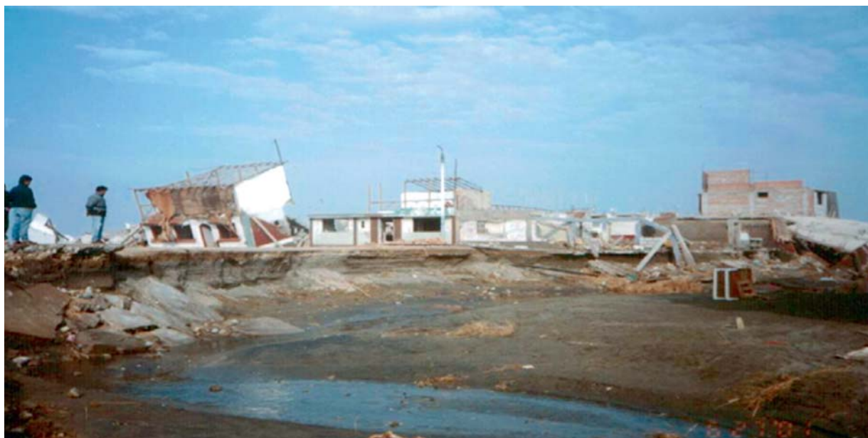
Daños en viviendas por efectos del tsunami - playa La Punta, provincia de Camaná, departamento de Arequipa, 23 de junio 2001
