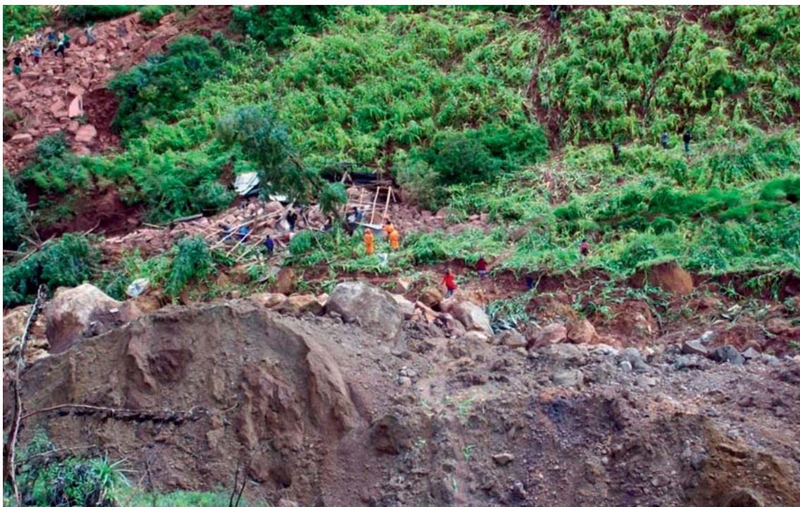
Viviendas destruidas por el deslizamiento
