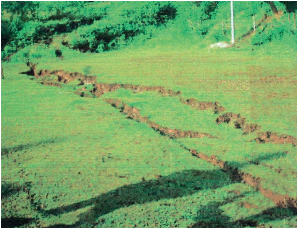
Foto 3: Agrietamientos del terreno, en otro sector de Shamboyacu
