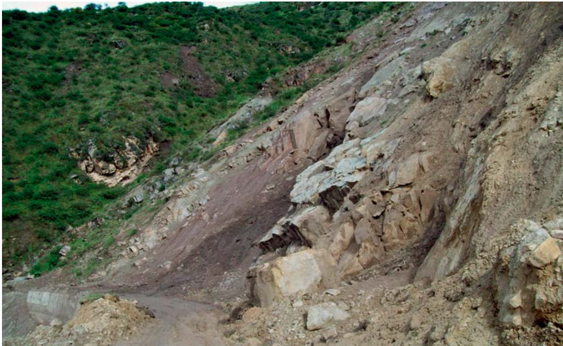
Cortes de taludes en la carretera, que generaron desestabilización de las laderas
