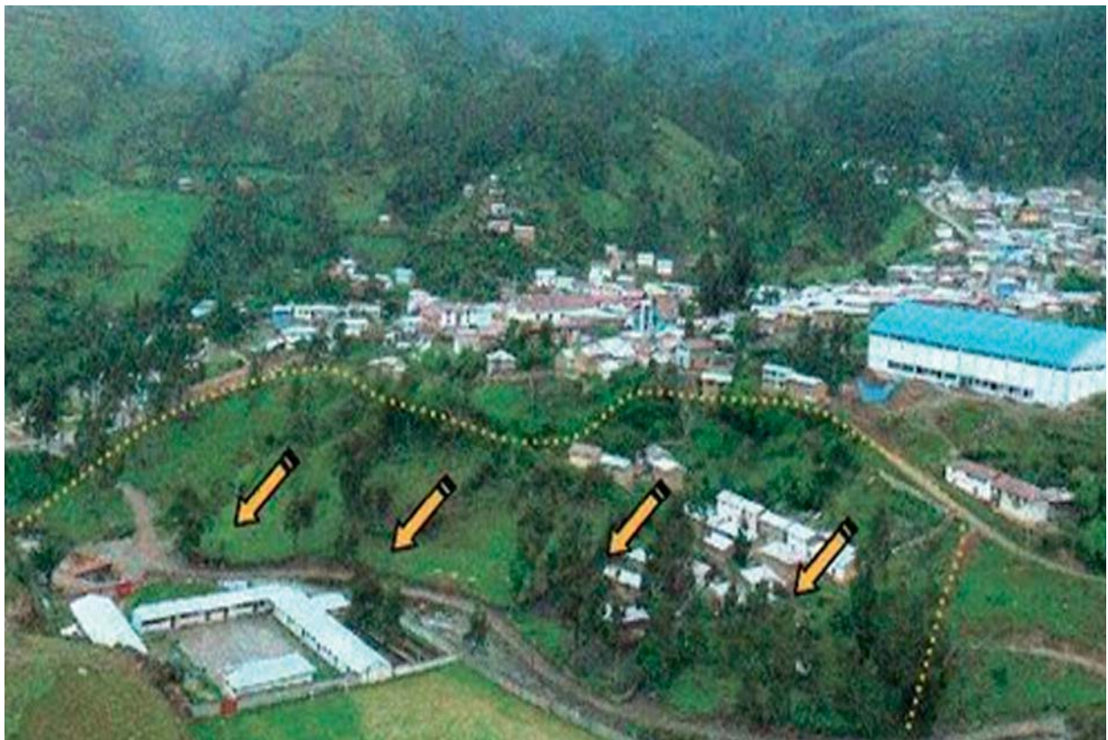
Según versiones de los pobladores e informes anteriores el área demarcada fue afectada por deslizamientos y reptación de suelos
