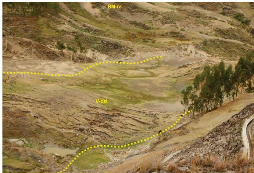
Figura 10. Vista en la se puede ver el depósito, con presencia de agrietamientos con presencia de aguas subterráneas, esta subunidad de ubica en las coordenadas UTM 9102732 N, 789936 E con una altitud de 3416 m s.n.m.
