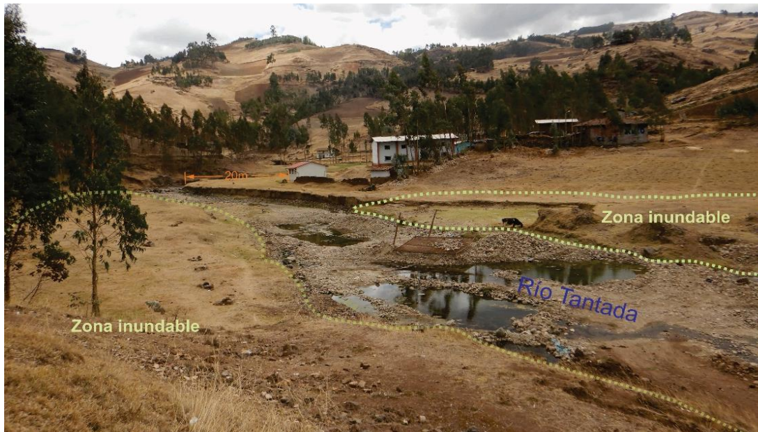
Figura 20. Vista con dirección noreste, donde se puede observar las zonas inundables del caserío, ubicada en las coordenadas UTM 9102328 N, 786597 E con una altitud 3250 m s.n.m.
