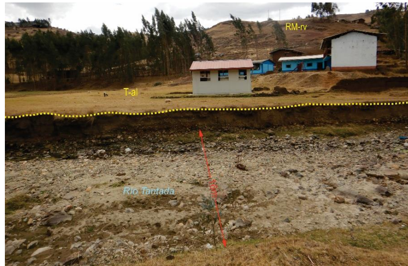
Figura 11. Vista donde se observa los centros educativos del caserío Las Palmas asentadas sobre esta unidad, Ubicado en las coordenadas UTM 9102229 N, 787018 E con una altitud de 3551 m s.n.m.
