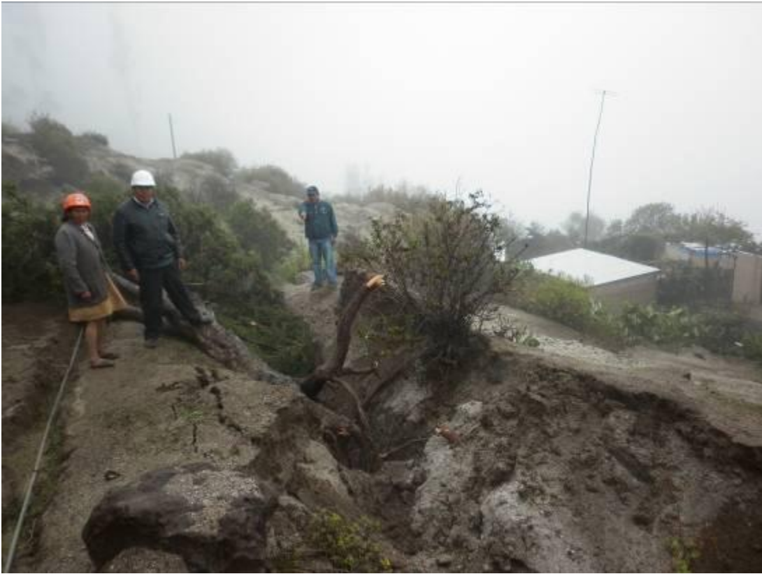
Zanjas pronunciadas con relleno de material propio
