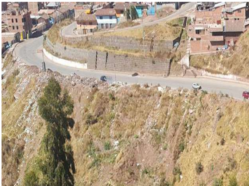
FOTOGRAFÍA 5: BOTADERO DE DESMONTE EN LA QUEBRADA SIPASMAYO
