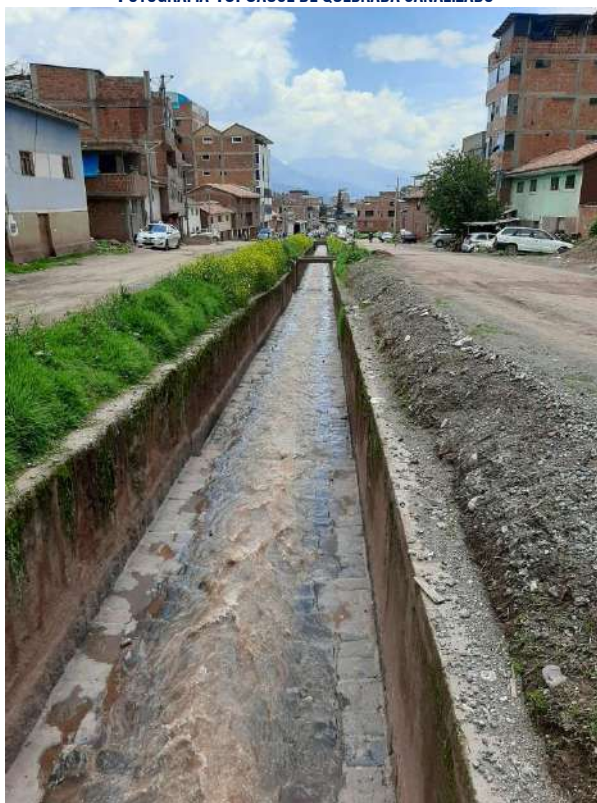
FOTOGRAFÍA 13: CAUCE DE QUEBRADA CANALIZADO
