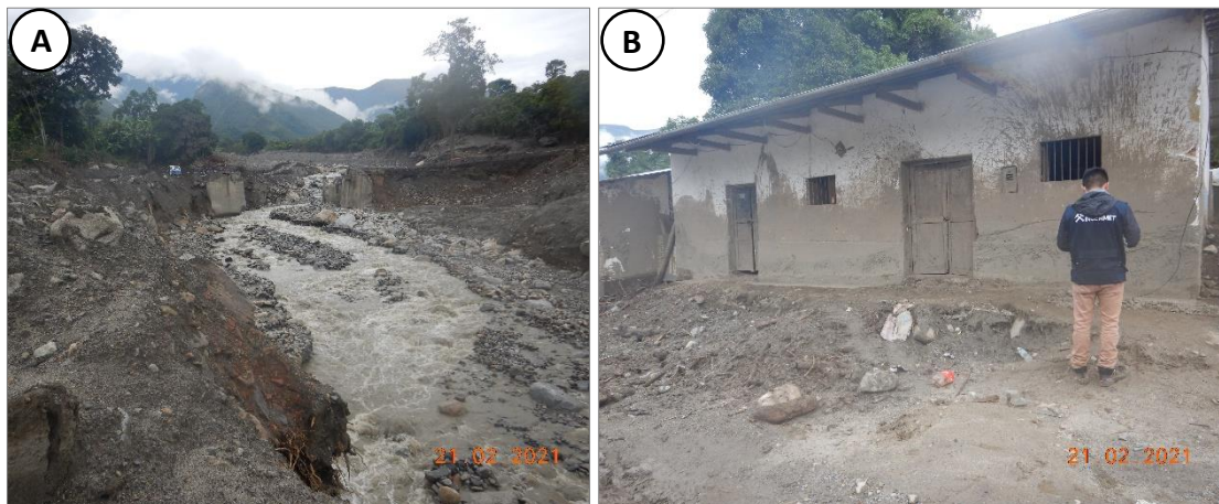
Figura 10. A) Puente Cocabambilla colapsado, medio de acceso al sector Pan de Azúcar. B) Vista de viviendas del sector Pan de azúcar afectados.
