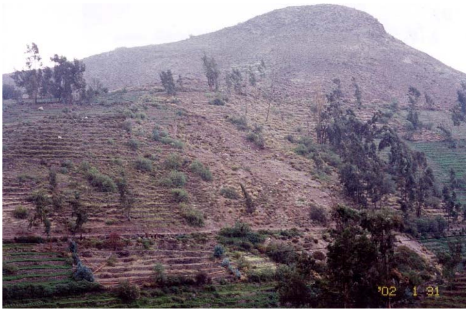
Foto 15.- Vista a un tramo de la carretera a Chucatamani, a unos 100 metros del desvío, se puede apreciar un deslizamiento que ha removido material aluvial, afectando, en parte, al sistema de andenes existente en el cerro Pucará.
