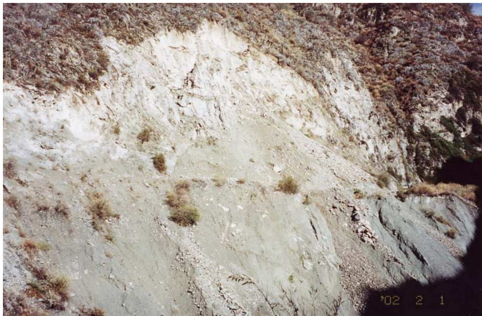
Foto 08.- Vista a uno de los cortes de la carretera Tarata-Ticaco donde afloran rocas intrusitas. A consecuencia del alto grado de meteorización de las rocas, se producen derrumbes y caídas de bloques.
