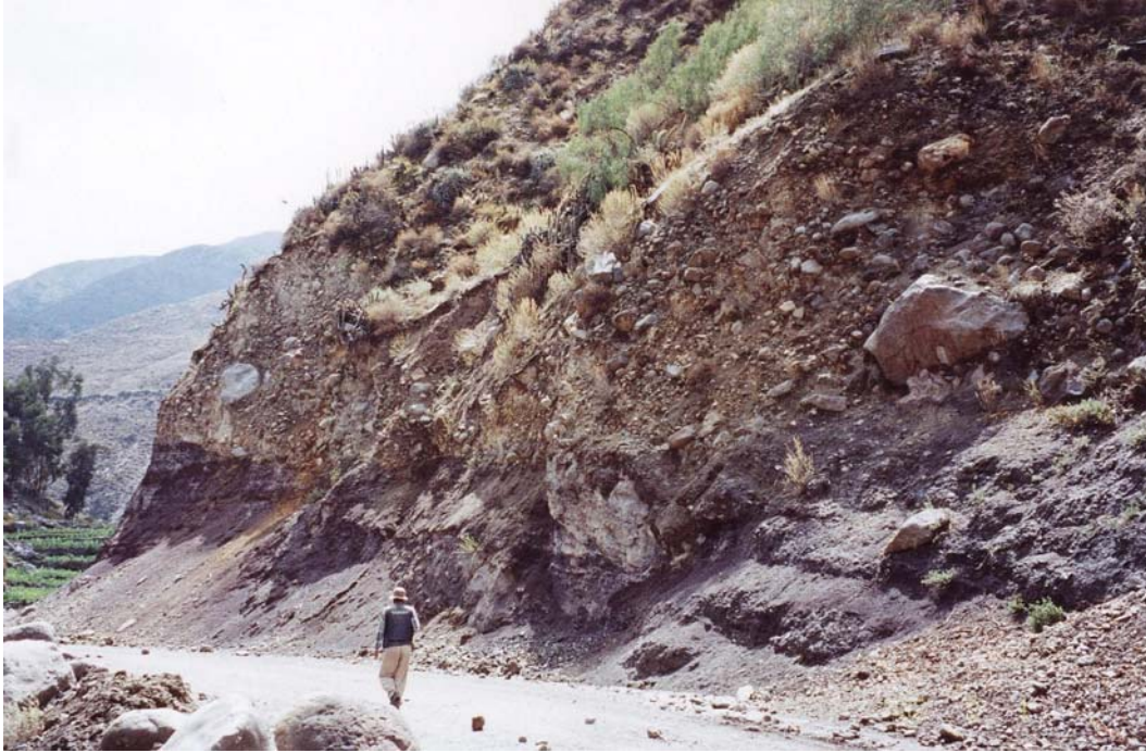
Foto 02.- Corte de la carretera Tarata-Ticaco. En la vista, afloramiento de la Formación Tarata compuesto de niveles sedimentarios finos de tonalidades violáceos, cortado por depósitos aluviales cuaternarios. En la carretera se aprecian bloques desprendidos de estos depósitos.
