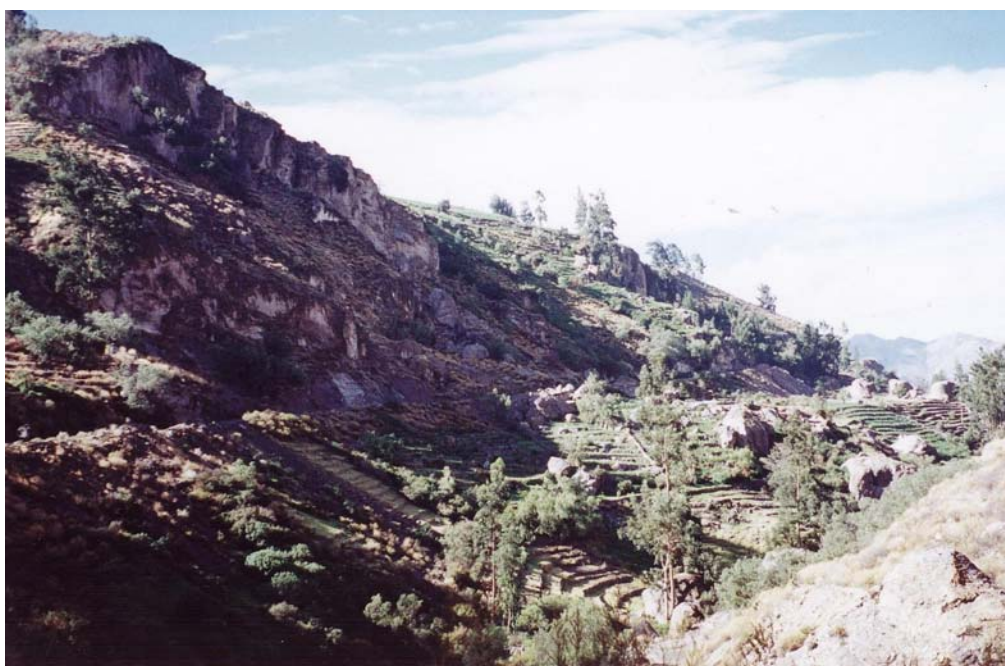
Foto 12.- Deslizamiento antiguo en un tramo de la carretera Tarata-Ticaco. Al pie del deslizamiento se aprecian bloques de roca de grandes dimensiones. Actualmente, se siguen desprendiendo bloques colgados en la escarpa.
