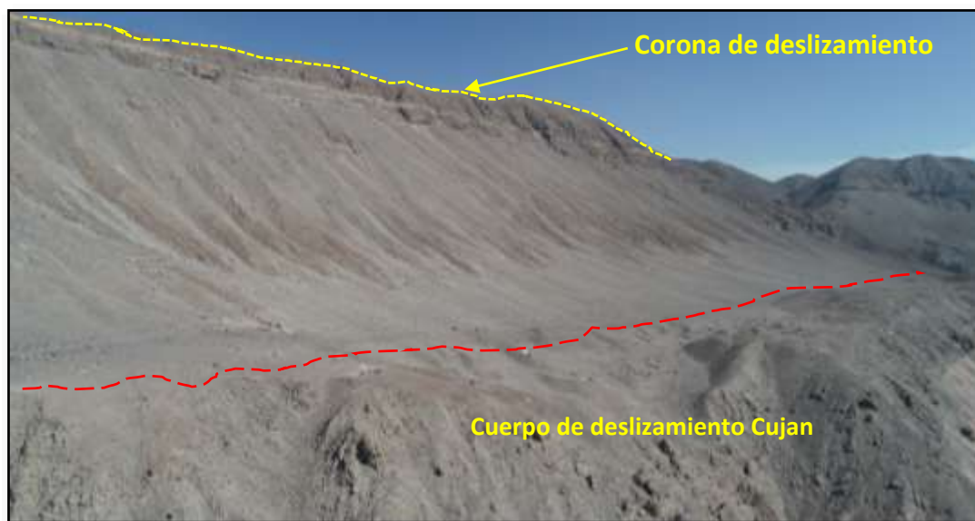
Figura 7. Escarpe de deslizamientos antiguos en el sector Cujan, (coordenadas UTM E: 807420, N: 8192435).
