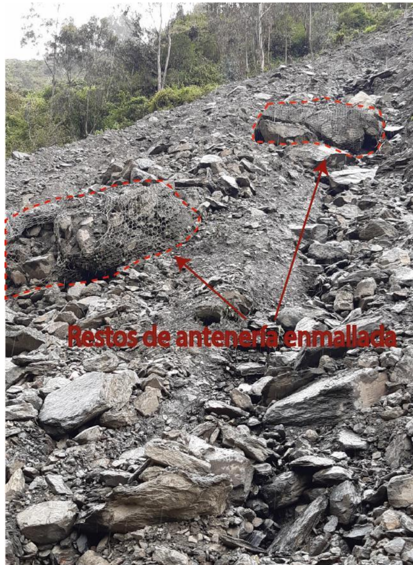
Figura 15. Se observa restos de andenería enmallada, el cual fue arrastrado por el cuerpo del derrumbe ladera abajo en el sector Llamani
