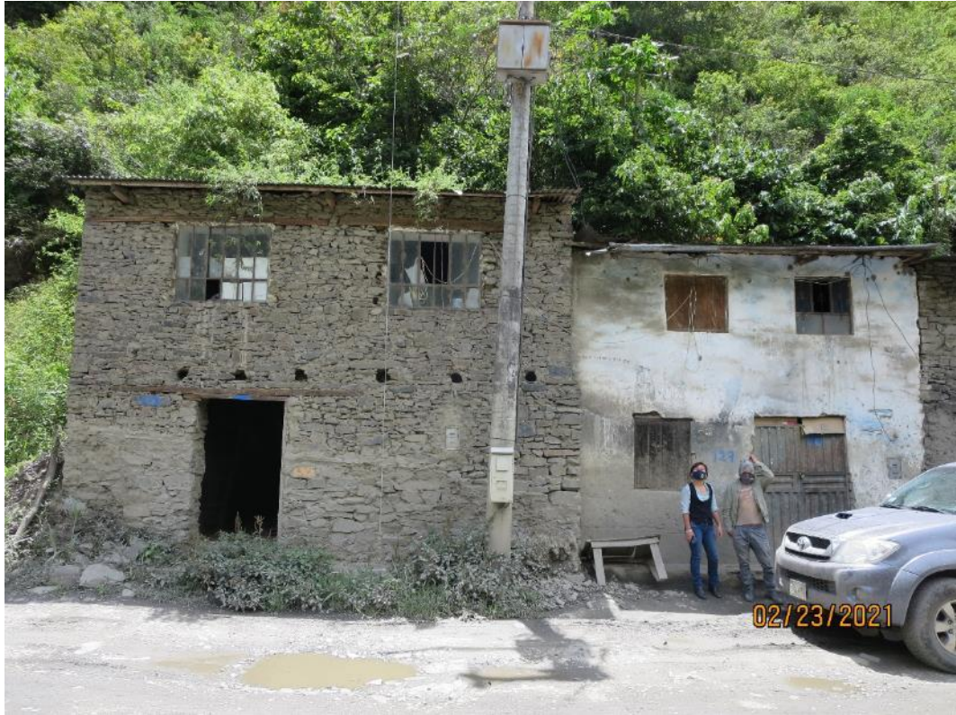
Fotografía 4. Viviendas asentadas en la desembocadura de la quebrada que discurre hacia el río ubicada en el sector Huancaluque.
