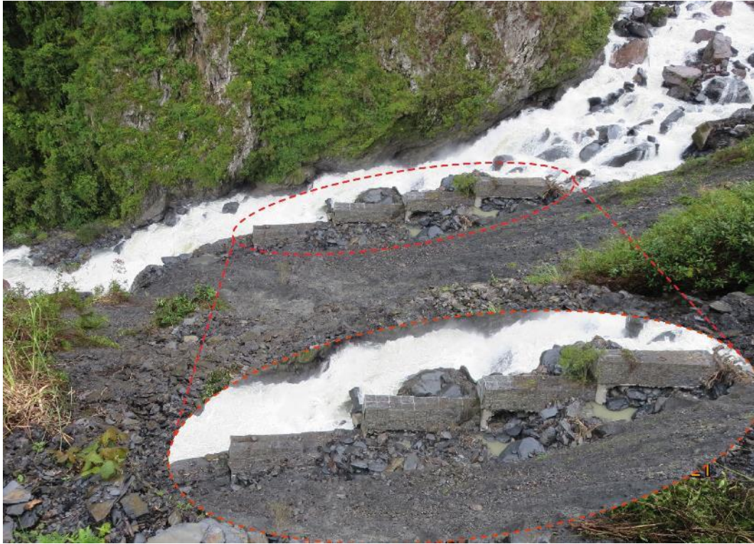
Figura 18. Imagen tomada hacia el pie del derrumbe en el sector Pampallani, se observa muros de defensa ribereña del río Sandia.
