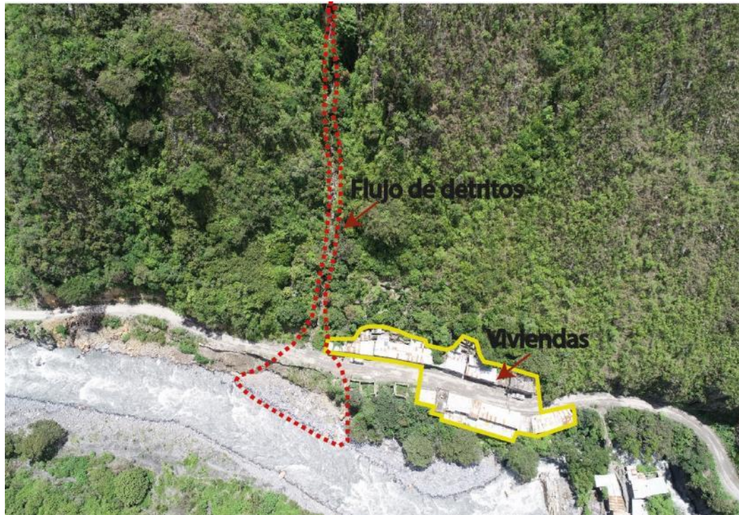
Figura 11. Imagen tomada con dron, se observa el curso que tuvo el flujo de detritos hasta desembocar en el río Sandía, del mismo modo se observa viviendas asentadas en la desembocadura de la quebrada, sector Huancaluque.
