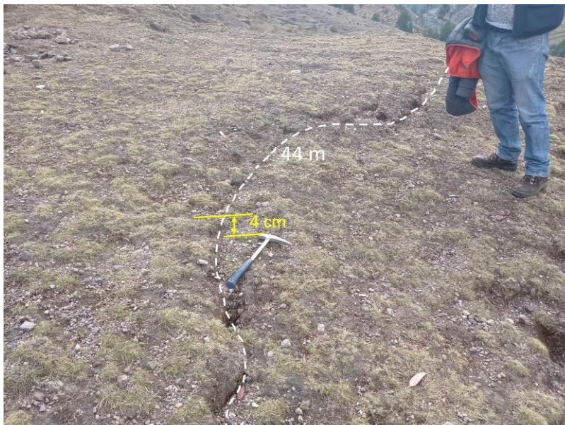
Figura 6. Vista tomada en coordenadas UTM E 238393; N 8465709. En la vista se aprecia una grieta que se generó el presente año.
