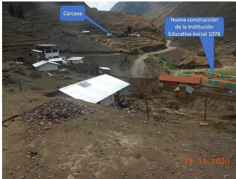
Figura 9. Vista tomada en coordenadas UTM E 238858; N 8466042. En la vista se aprecia el dren principal y la nueva construcción de la I.E. Inicial 1078 que puede ser afectada por la cercanía a este dren.
