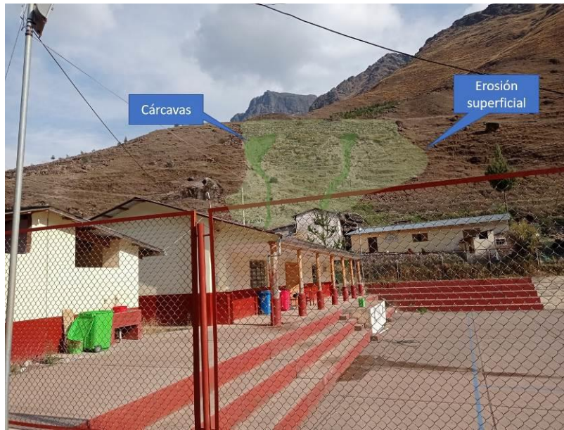
Figura 7. Vista tomada en coordenadas UTM E 238243; N 8465794. En la vista se aprecia la erosión superficial y las cárcavas que generaron el flujo de detritos en el patio del colegio Javier Heraud.
