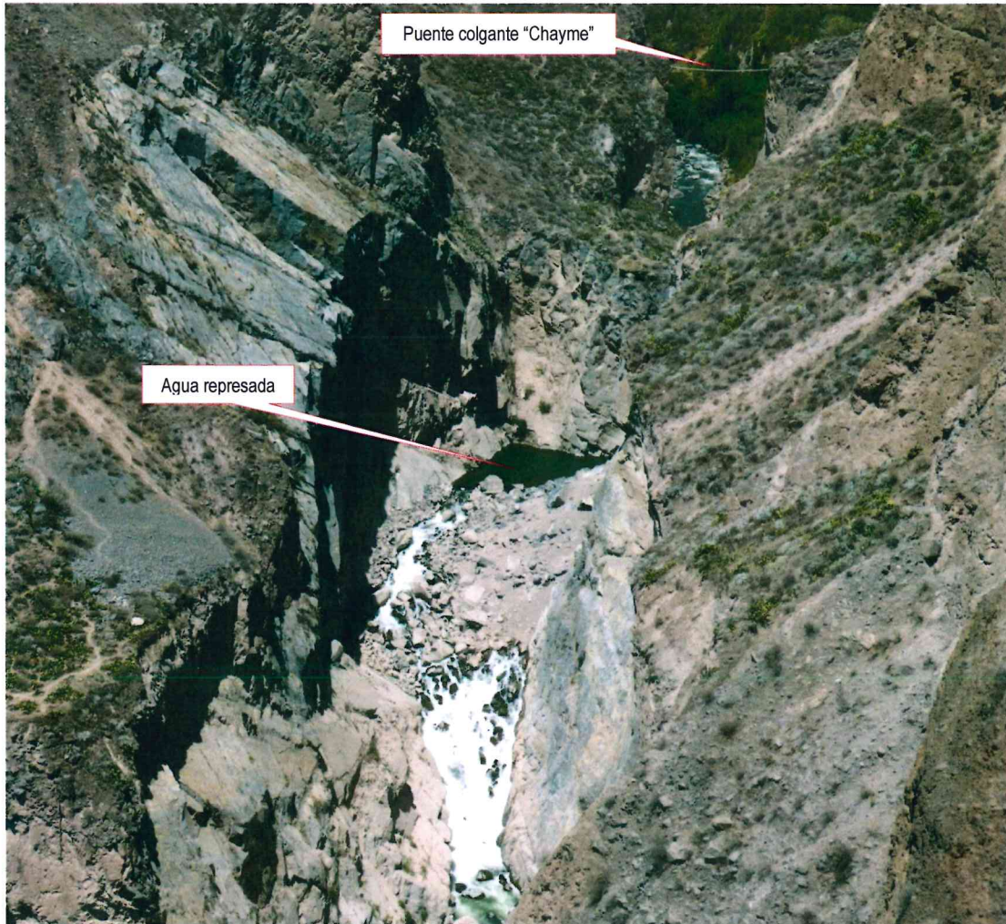
Foto 15. Vista aguas del represamiento del río Cotahuasi
