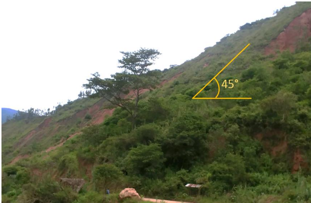
Figura 7. Sector afectado ubicada al suroeste de la zona de estudio.
