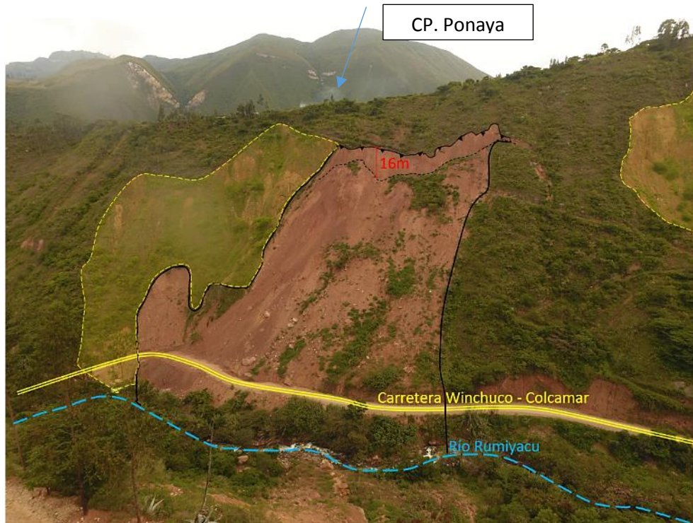
Figura 11. Vista panorámica del deslizamiento, altura de escarpe de 16 m y una fuerte erosión de laderas en el entorno del deslizamiento.
