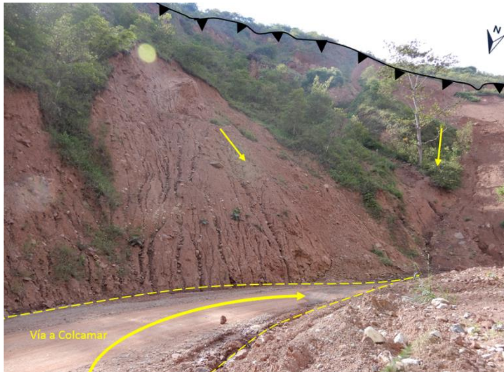
Figura 14. Se aprecia la vía que discurre sobre el cuerpo del deslizamiento. En el corte de talud se parecían escorrentía lo que muestra que es de fácil erosión.
