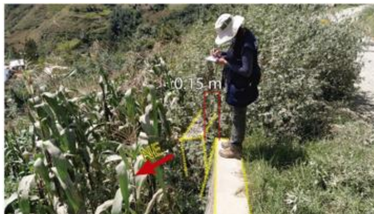
Figura 35. Inclutación de muros de contención en la carretera de acceso a Tambillo desde el caserío de Panaochocha.
