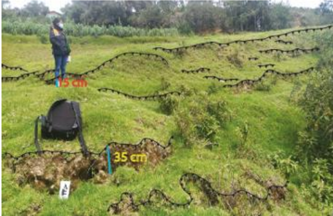
Figura 29. Escarpes de reptación que varían desde 15 cm a 35 cm de altura.
