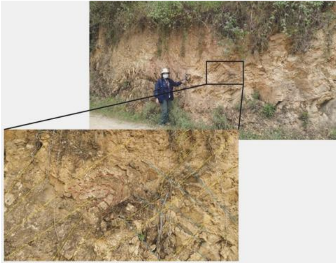
Figura 7. Muestra el alto grado de fracturamiento y meteorización de los esquistos del complejo Marañón. Coordenadas UTM (WGS 84): 387664 E, 8910138 S, a 2817 m s.n.m.
