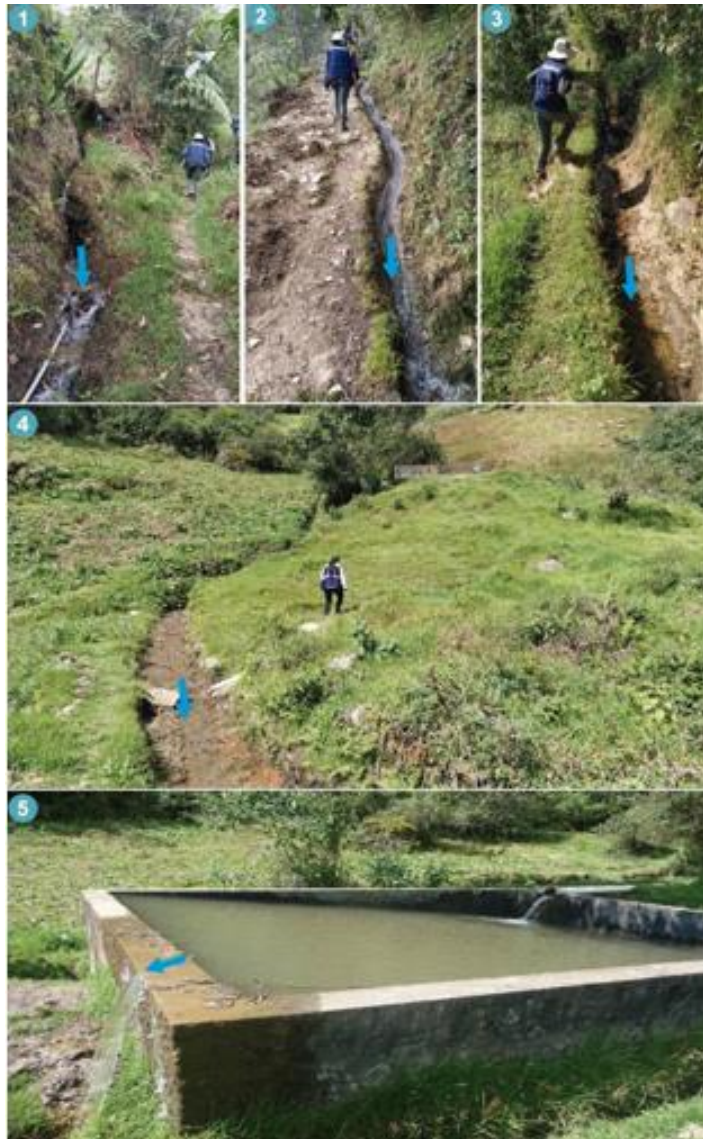
Figura 21. Del 1 al 4, se observan, canales de riego no impermeabilizados, 5) muestra el rebalse de un reservorio de agua inclinado aproximadamente 10 °, que vierte su excedente de agua al terreno.
