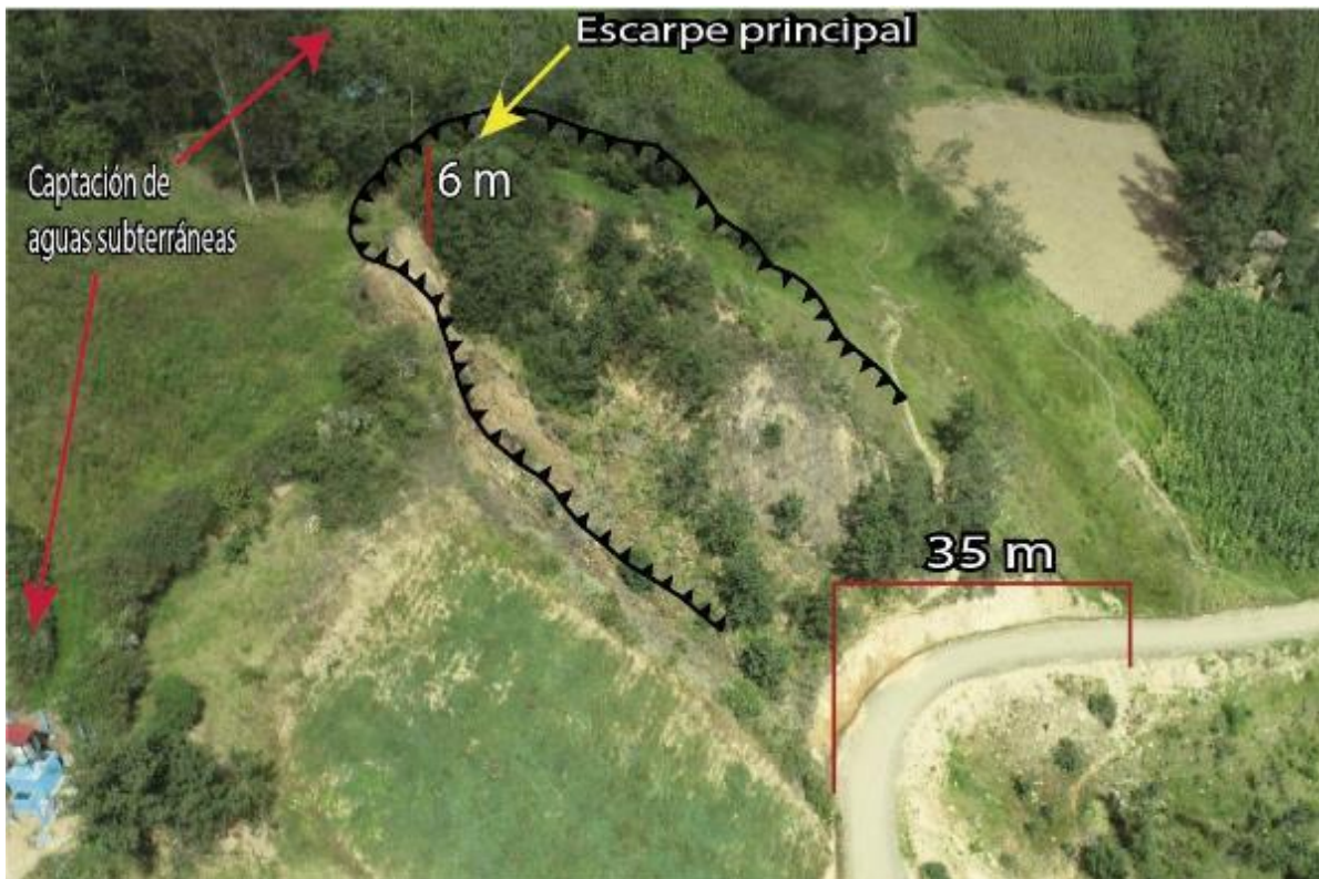
Figura 24. Escarpe principal del deslizamiento Cochapampa, y la vía afectada en 35m.
