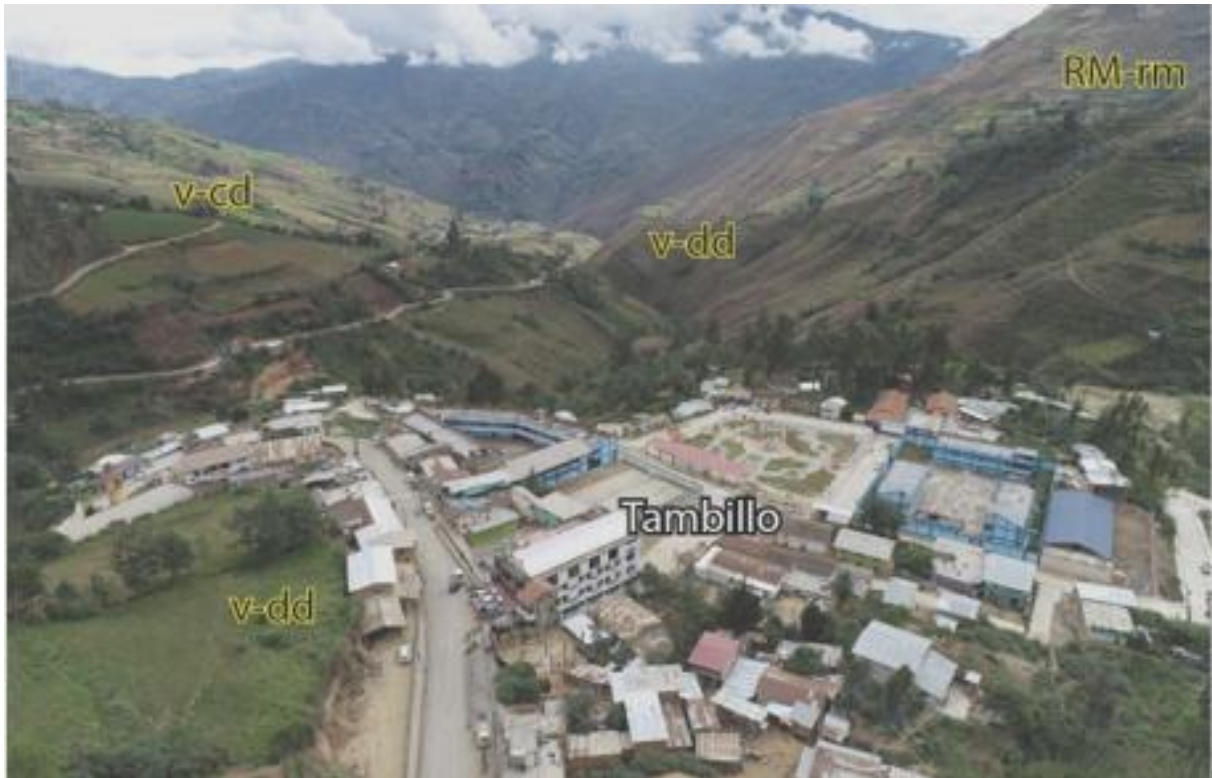
Figura 12. Vista del C.P. Tambillo, el cual se encuentra ubicado en una vertiente con depósito de deslizamiento antiguo.
