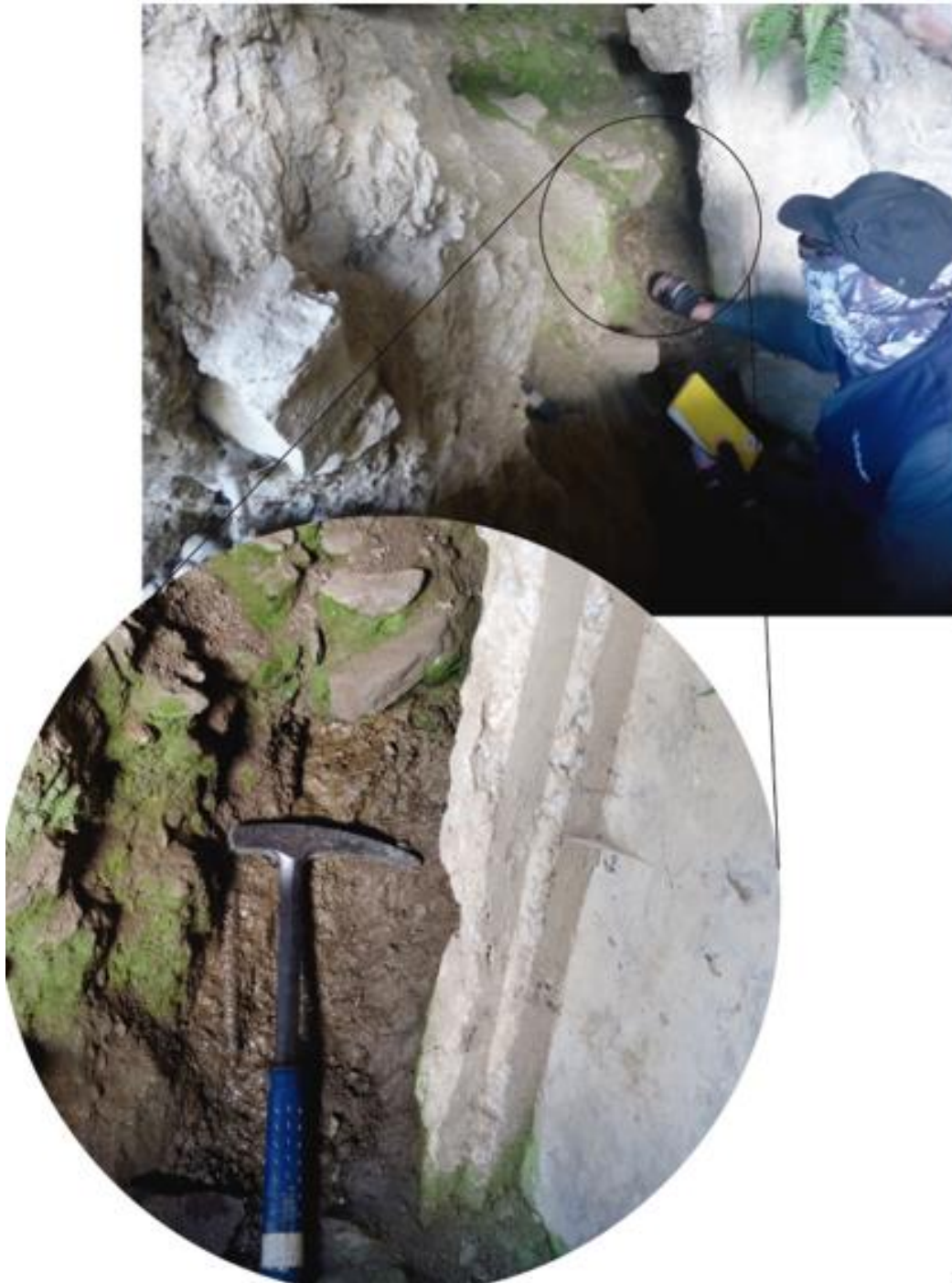
Figura 9. Depósitos coluvio-deluviales poco consolidados, con infiltraciones de agua, sobre los que se han construido las viviendas en el centro poblado de Tambillo. Coordenadas UTM (WGS 84): 385658 E, 8909422 S, a 2540 m s.n.m.
