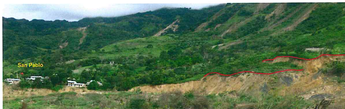
Foto 7. Lado derecho del deslizamiento, se aprecia la escarpa principal y por detrás de ella se está formando otra escarpa. Vista hacia el suroeste del deslizamiento.
