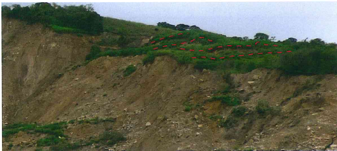
Foto 6. Se aprecia escarpas que se están formando atrás de la escarpa principal. Que indica su inestabilidad. Vista hacia el noroeste.
