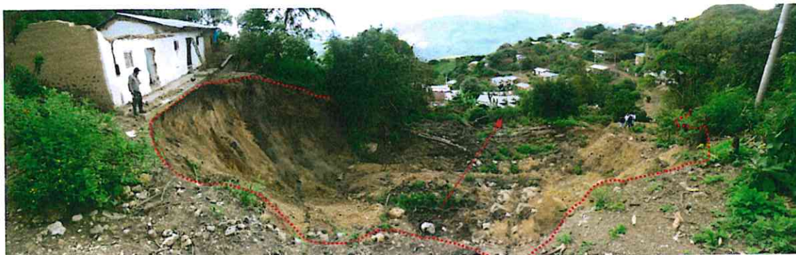
Foto 17. Se aprecia la corona del deslizamiento de Mesarrume. Su depósito se dirige hacia el poblado de Mesarrume. Vista en dirección suroeste al noreste.
