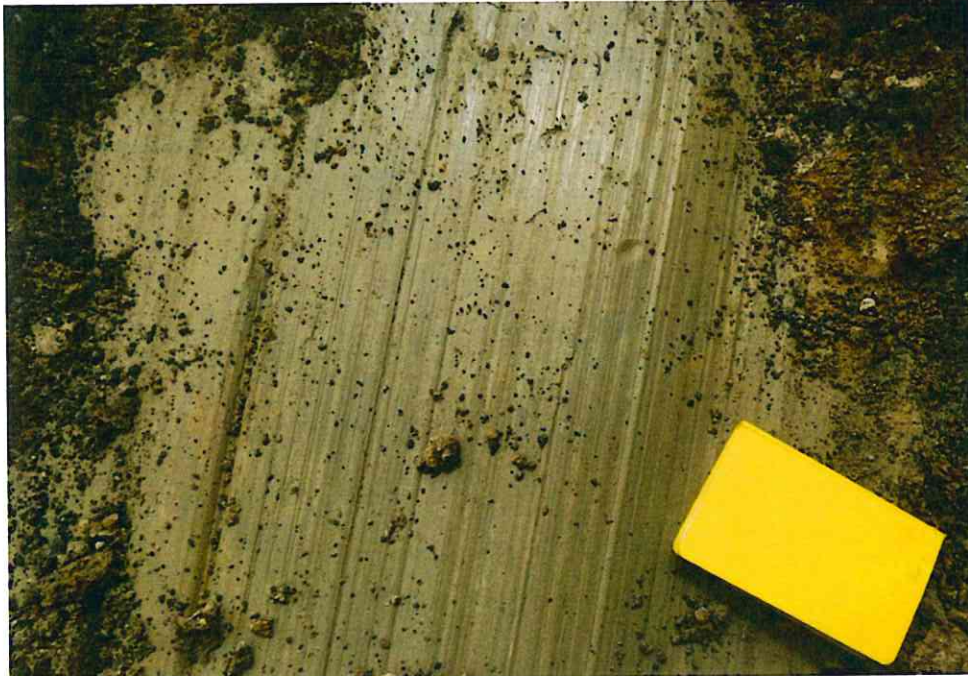
Foto 23. Se muestran las estrías formadas en la escarpa principal del deslizamiento.
