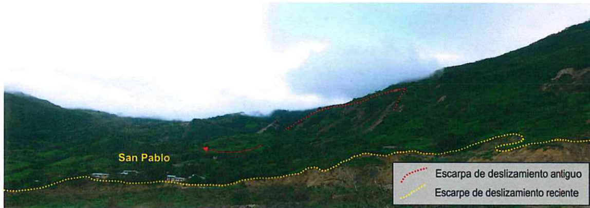
Foto 38. Vista del deslizamiento antiguo, donde se encuentra asentado el caserío de San Pablo.
