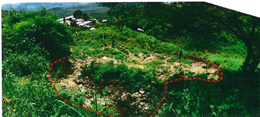
Foto 29. Vista de la escapa principal hacia el poblado de Mesarrume.
