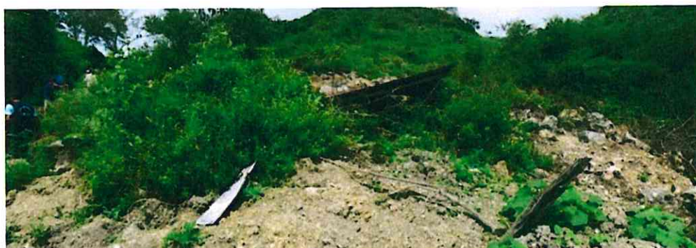
Foto 31. Casa afectada por el deslizamiento, ubicada en el cuerpo del deslizamiento.
