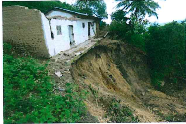
Fotos 19 y 20. Escarpa principal del deslizamiento, la izquierda tomada el 14 de mayo 2015, la derecha tomada el 17 de marzo del 2015. Se aprecia en avance de la escarpa.
