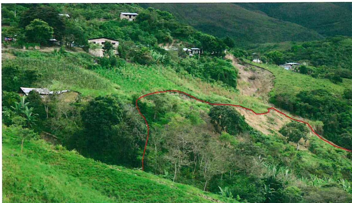
Foto 33 Vista del poblado de Mesarrume, delimitado con línea roja se aprecia la cabeza del deslizamiento, formado por debajo del poblado. El avance retrogresivo de este deslizamiento comprometería las viviendas inmediatas a la escarpa principal.
