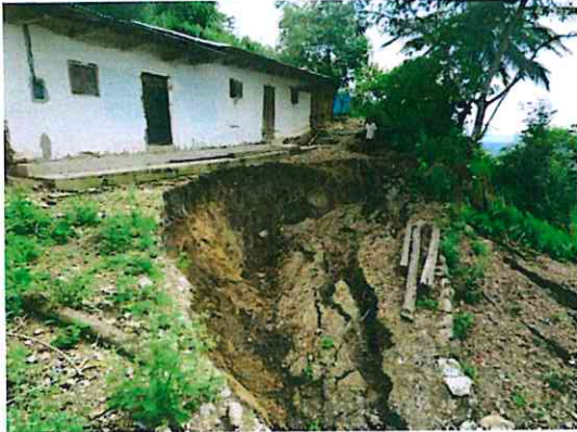
Fotos 19 y 20. Escarpa principal del deslizamiento, la izquierda tomada el 14 de mayo 2015, la derecha tomada el 17 de marzo del 2015. Se aprecia en avance de la escarpa.
