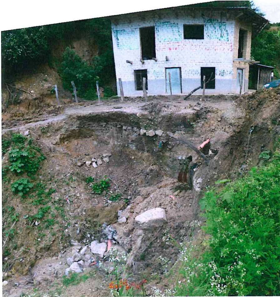
Foto 35. Otro sector con erosión en cárcava, de seguir el proceso, va afectar a vivienda. Vista cercana al centro educativo de Mesones Muro.
