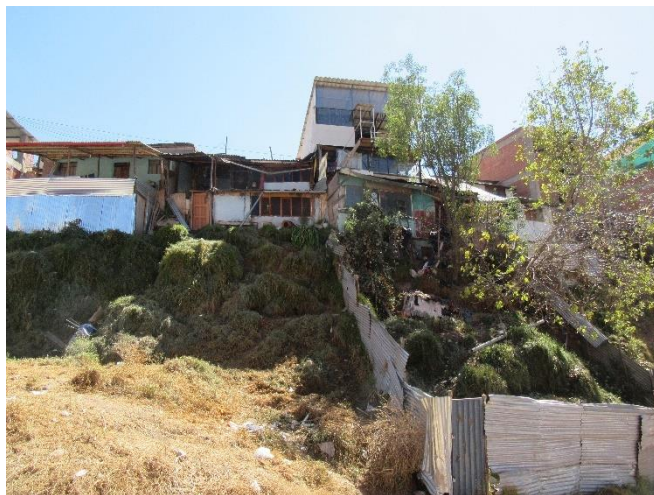
Fotografía 1: Evacuación de aguas pluviales en las zonas de áreas verdes en la ZRESA06 Fuente: Equipo Técnico PM41ZRE
