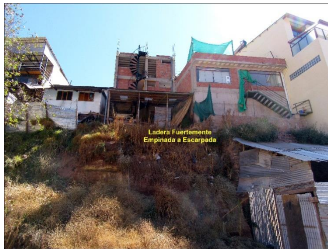
Fotografía 18: Ladera fuertemente empinada a escarpada Fuente: Equipo Técnico PM 41 ZRE
