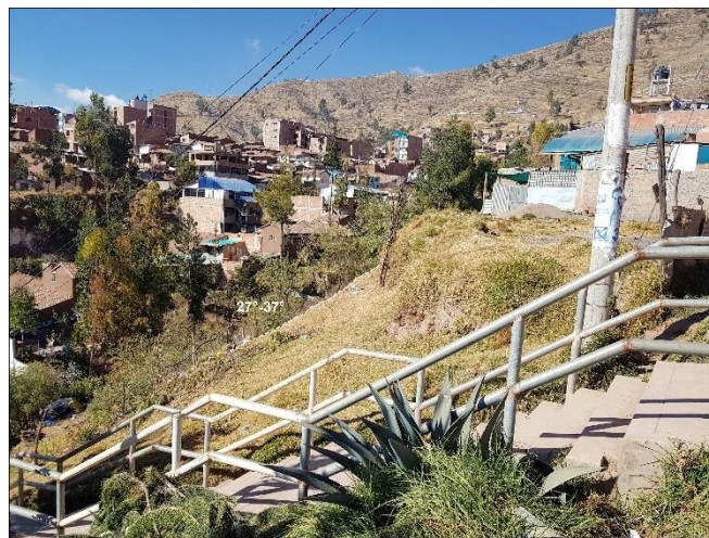
Fotografía 12: Pendientes fuertemente empinado en ladera de quebrada margen izquierda.
