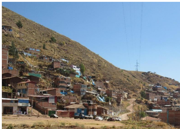
Fotografía 2: Área de servidumbre de la red de alta tensión en la ZRESA06 Fuente: Equipo Técnico PM41ZRE
