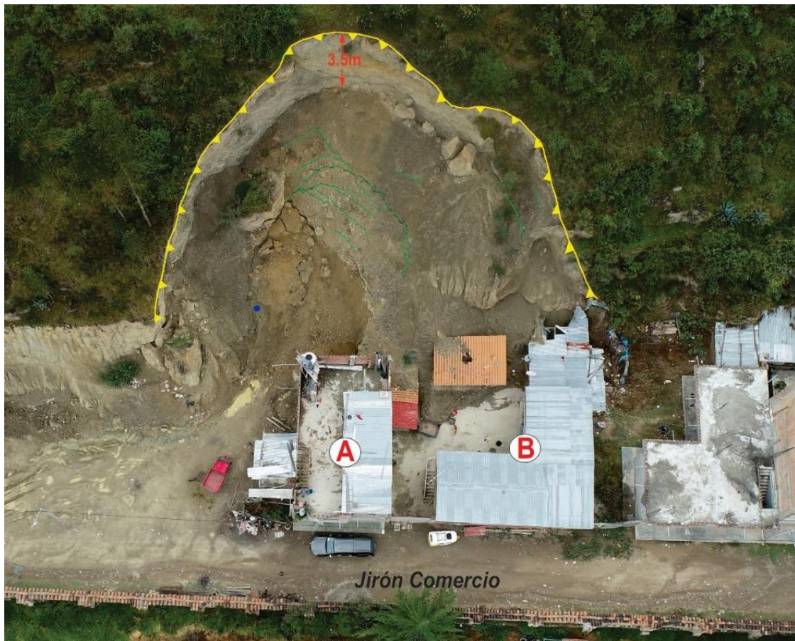
Figura 17. Vista tomada con el dron, donde se puede visualizar las grietas transversales con longitudes de hasta 13 m (líneas punteadas de color verde); emanación de agua subterránea
