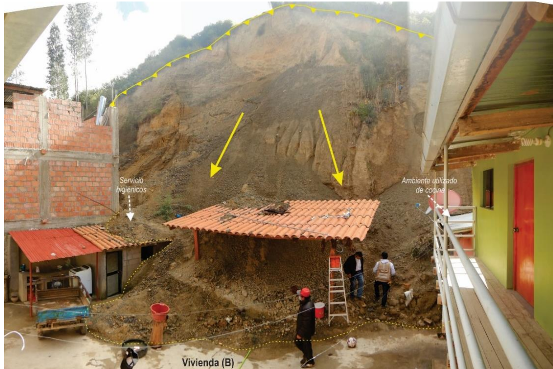
Figura 18. Vista donde se observa el material del deslizamiento depositado en medio del patio de la vivienda (B), según información del propietario, el material se deslizó en varias oportunidades; pero con menor cantidad, la cual facilitaba la limpieza; actualmente no lo están haciendo por temor a una reactivación.
