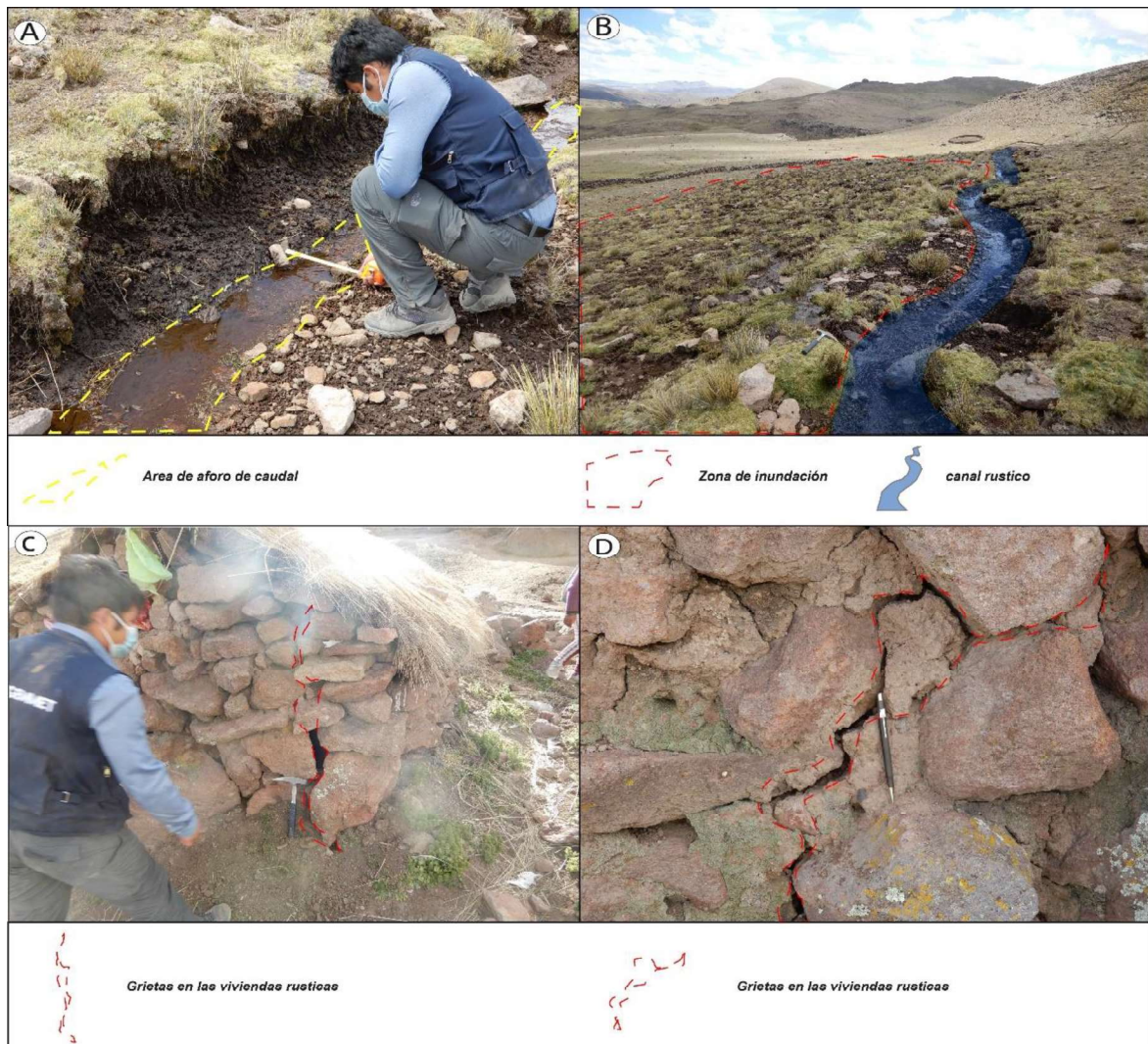
Figura 08. A) Se muestra el caudal de la quebrada. B) Se ha delimitado el área de inundación y canal rustico. Ubicación flanco izquierda del deslizamiento (UTM: 246651 E, 8313330 N, 19L). C y D)) claramente se observa grietas en las viviendas rusticas. Ubicación: cuerpo de deslizamiento (UTM: 246416 E, 8313384 N, 19L).
