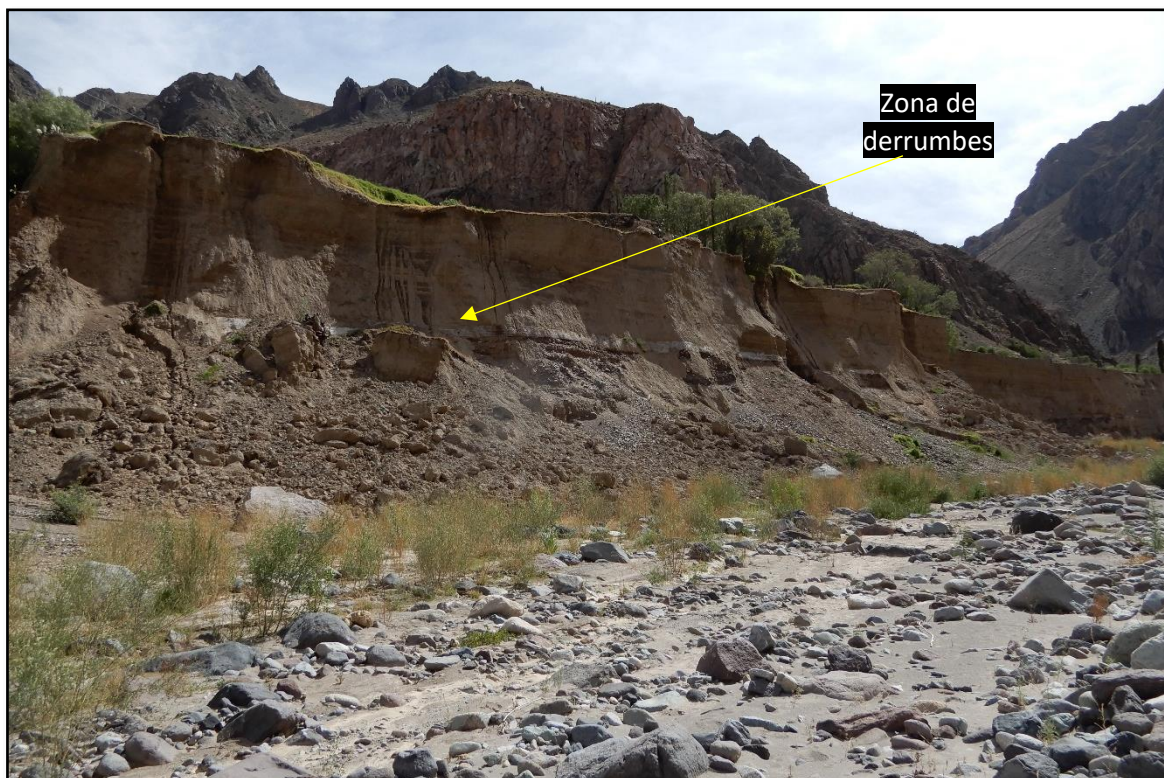
Figura 12. Zona de derrumbes. (coordenadas UTM E: 792489., N: 8335672).
