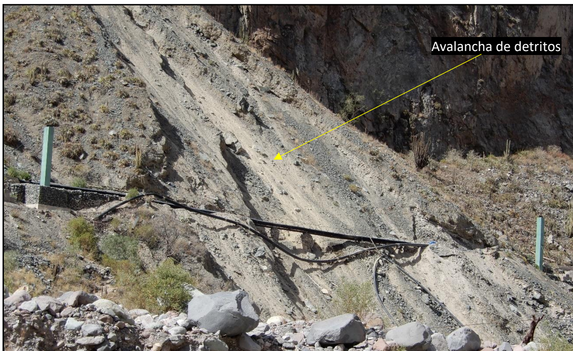
Figura 14. Avalancha de detritos en la margen izquierda del río Tambo, se ubica en la siguiente coordenada UTM: (E: 792616., N: 8335389; b)
