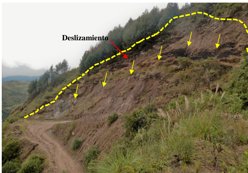
Figura 5. Vista del sector con coordenadas 720776 E/ 9247955 N, nótese desplazamientos recientes en el talud superior de la vía Chorro Blanco – La Libertad.
